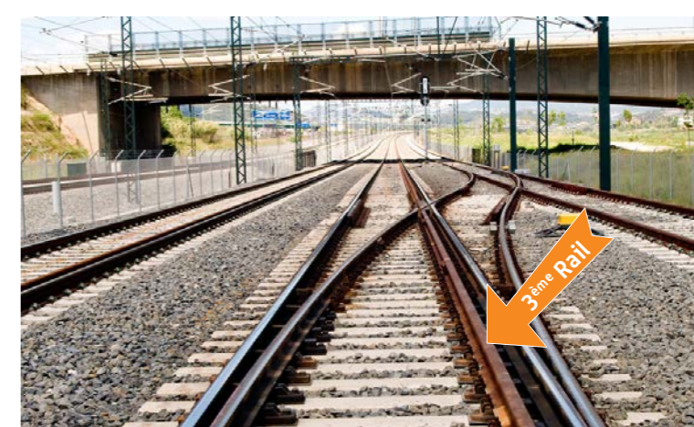
Troisième rail au Sud de la ligne nouvelle Perpignan-Figueras vers Barcelone (photo : Adil)
