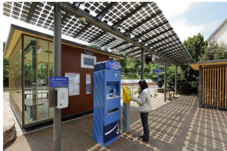
Halte ferroviaire écodurable de Niederbronn-les-bains avec toiture équipée de panneaux solaires (Crédit photo : SNCF-J.M. Dugas)
