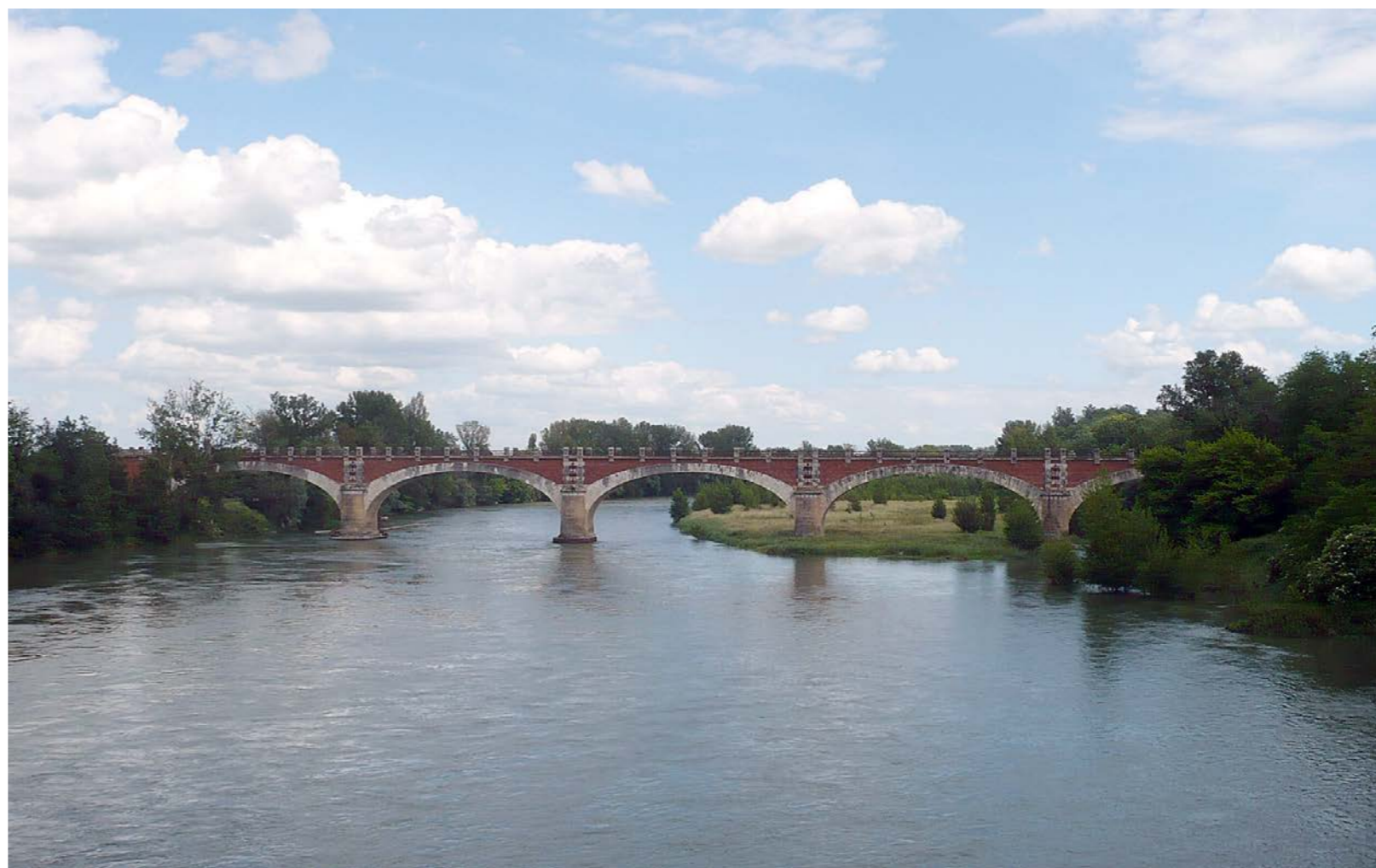
La vallée de la Garonne à Castelsarrasin (Source : Egis)
