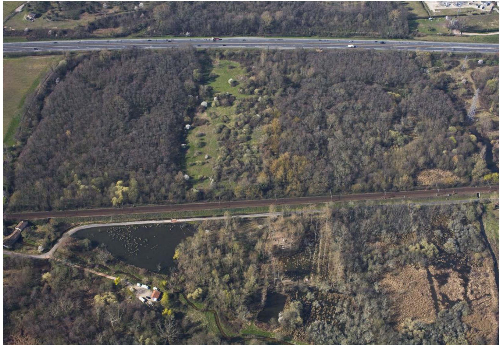
La ligne existante à proximité de la vallée de l'Eau Blanche (Source : RFF)
