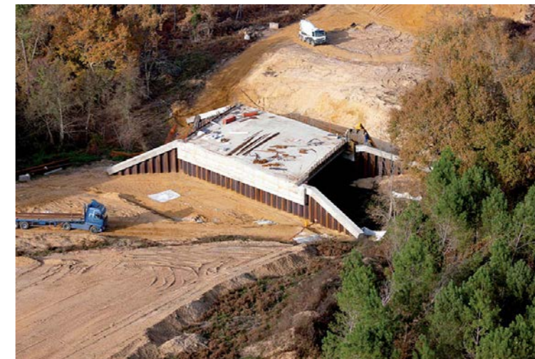
Mise en place d'un ouvrage de type portique avec préservation des berges (Source : Egis)
