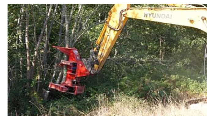
Abattage mécanique d'une ripisylve à 50 cm du sol minimum (P. Fournier - GREGE)
