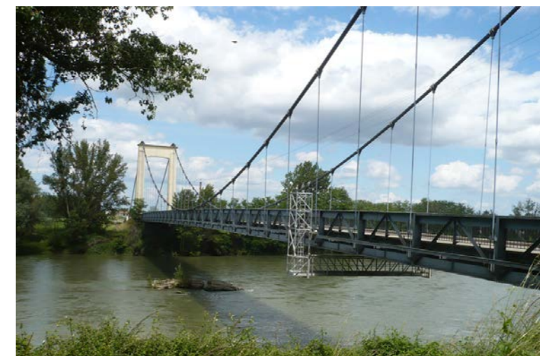
La Garonne au niveau du pont de Belleperche [Source : Egis, 2012]
