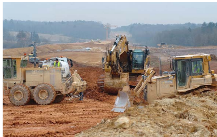
Travaux de terrassement sur un chantier (Source : RFF)
