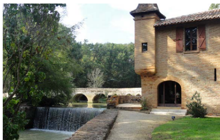
Le moulin à eau de la Théoule (Source : Egis, 2012)
