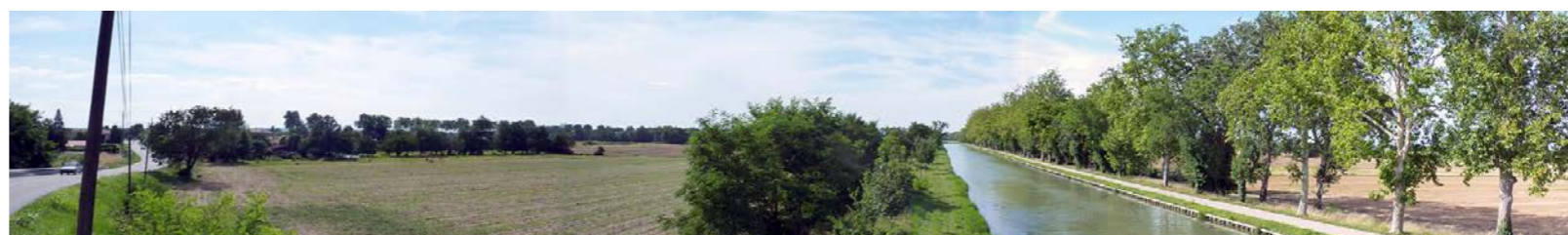
Vue sur le canal latéral à la Garonne, ses platanes et son chemin de halage [Source : Soberco, 2010]
