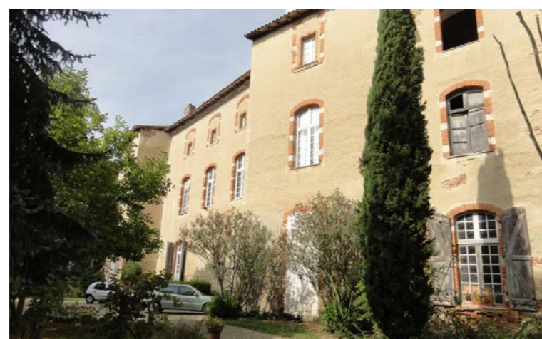
Le château de Castelferrus (Source : Egis, 2012)
