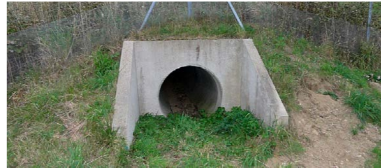
Ouvrage de type 3 (Source : Egis)
