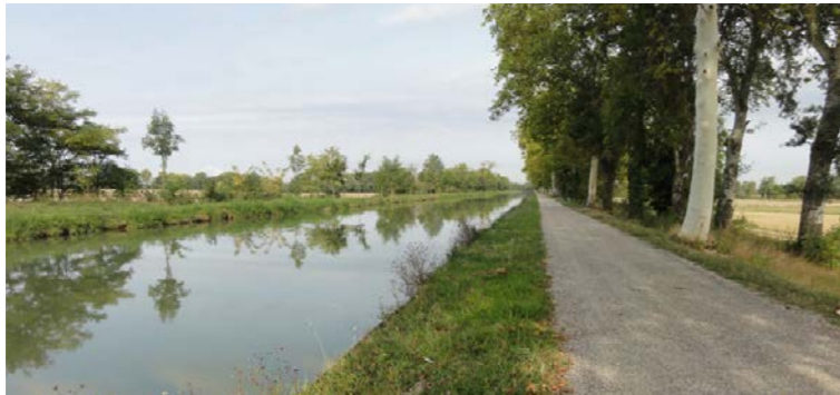
Canal latéral à la Garonne sur la commune de Saint-Porquier [Source : Egis, 2012]
