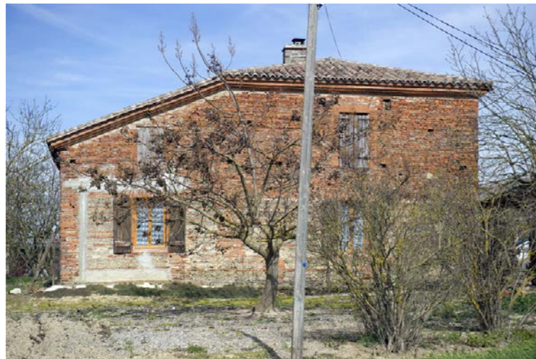
Bâti à Castelsarrasin (Source : RFF - Paul Robin)
