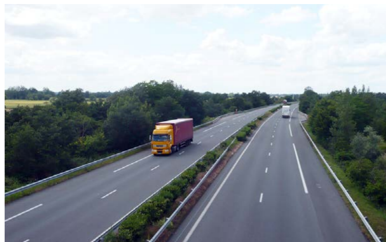
L'autoroute A62 au niveau du pont de la route départementale 14 sur la commune de Saint-Porquier (Source : Egis)
