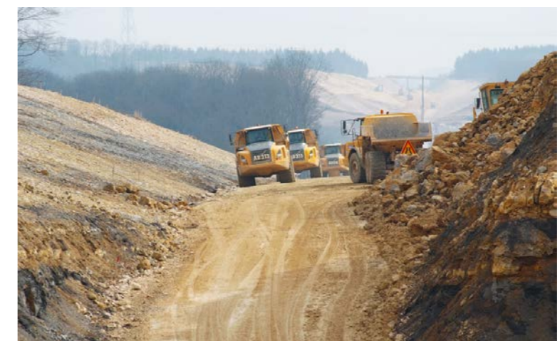
Dumpers sur un chantier (Source : RFF)
