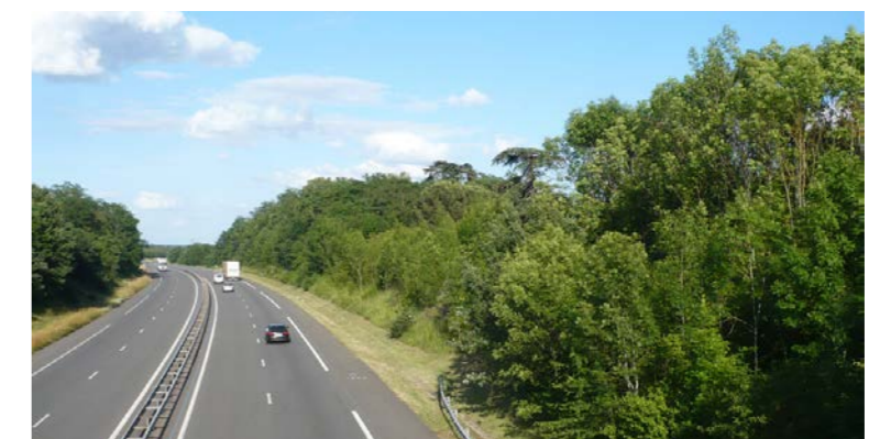
L'A62, commune de Saint-Michel [Source : Egis, 2012]
