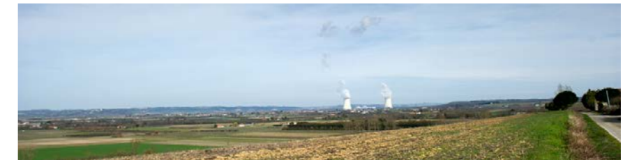
Vue sur la centrale nucléaire de Golfech depuis Dunes [Source : RFF-Paul Robin]
