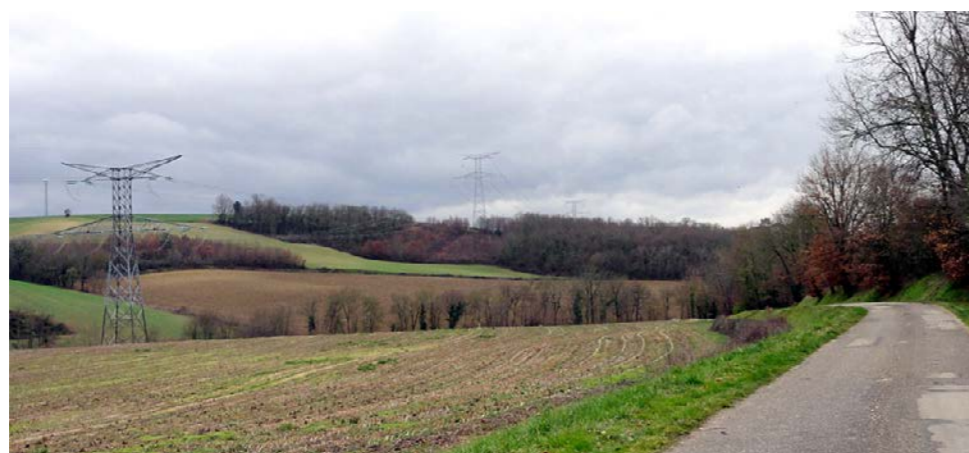
Vallée de la Caille depuis Barairou, Donzac [Source : Egis, 2013]
