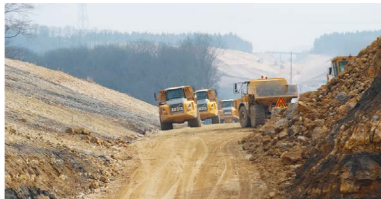
Dumpers sur un chantier (Source : RFF)
