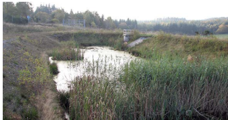
Exemple de bassin d'écrêtement [Source : Egis]
