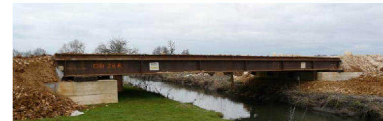
Exemple de pont provisoire préservant le lit mineur et les berges (Source : Egis)
