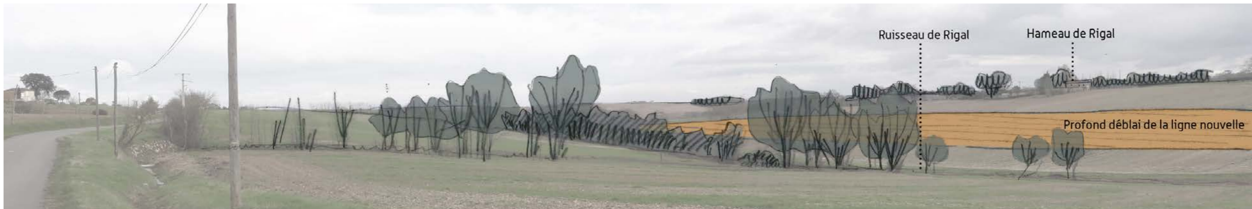
Croquis du déblai de Rigal sans mesures d'insertion paysagère, vue depuis Mangoué, Auvillar (Source : Egis, 2013)
