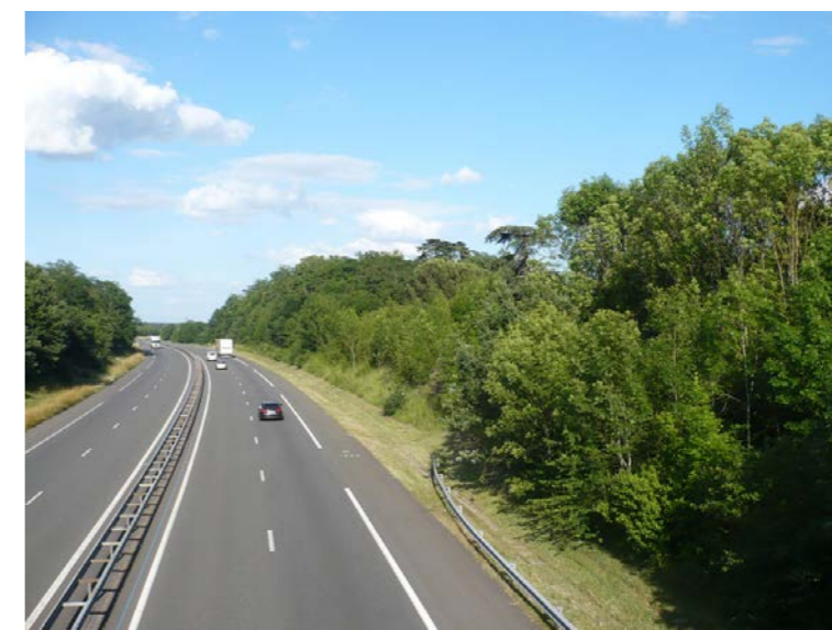
L'autoroute 62 depuis Candes sur la commune de Saint-Michel (Source : Egis, 2012)
