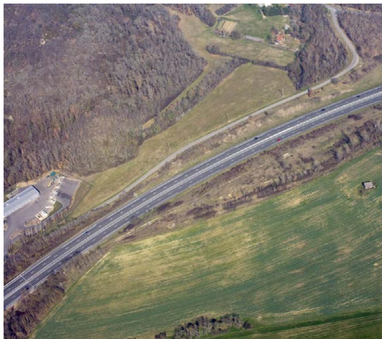
Sentier de randonnée au nord de l'A62 à Auvillar (boucle locale) rejoignant le GR 65 [Source : Réseau Ferré de France, 2012]
