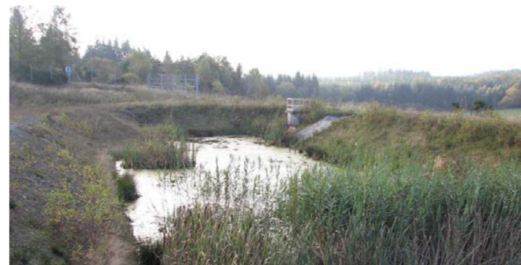
Bassin d'écroulement [Source : Egis]
