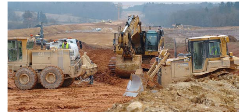
Travaux de terrassement sur un chantier [Source : RFF]
