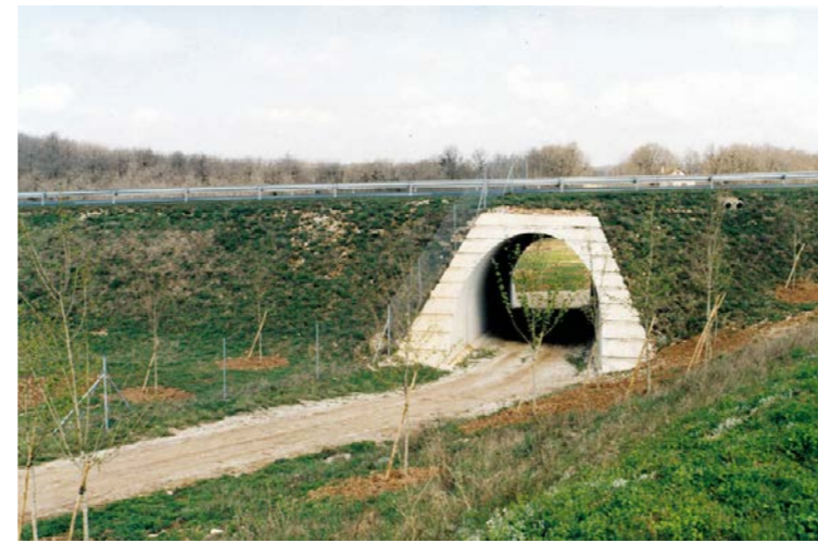
Exemple de rétablissement agricole (Source : Egis)
