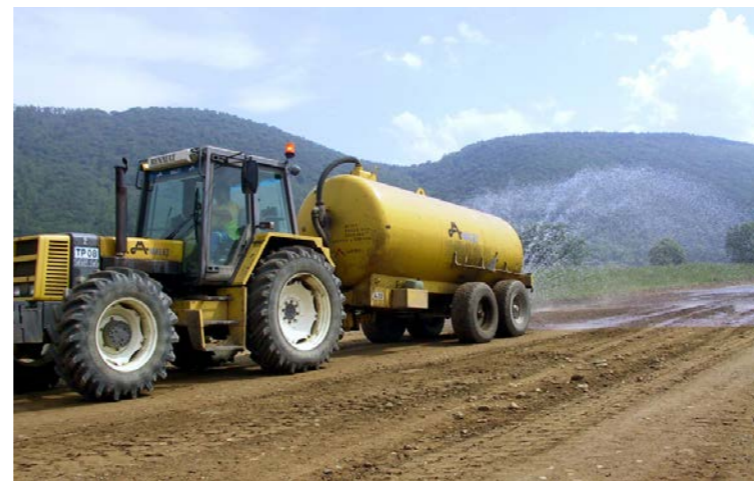
Arroseuse sur un chantier [Source : Egis]
