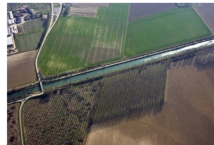
Vue sur le Canal Latéral à la Garonne sur la commune de Montesquieu [Source : RFF, 2012]
