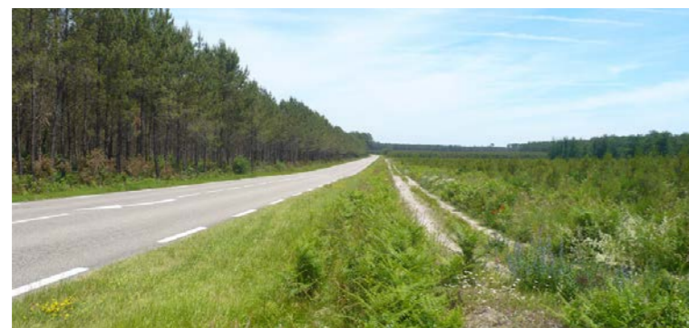
Route départementale 8 traversant la commune d'Ambrus [Source : Egis, 2012]
