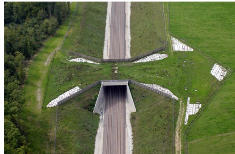
Exemple de passage grande faune
