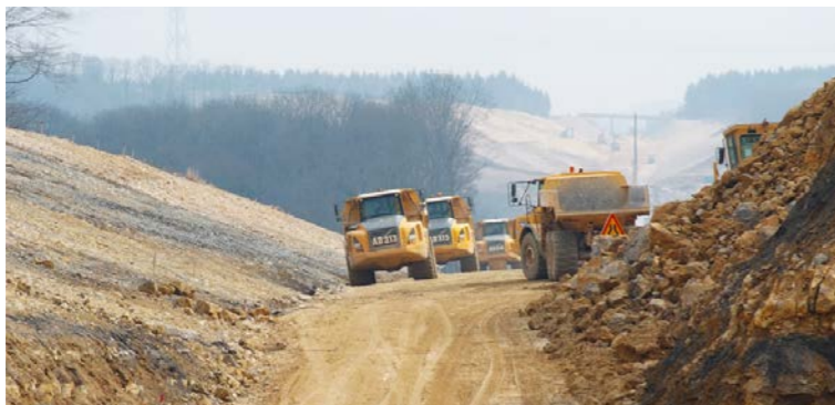
Dumpers sur un chantier [Source : RFF]
