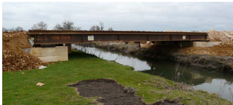
Exemple de pont provisoire préservant le lit mineur et les berges (Source : Egis)
