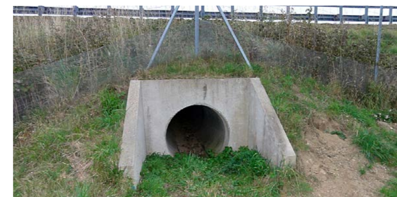
Ouvrage de type 3 [Source : Egis]
