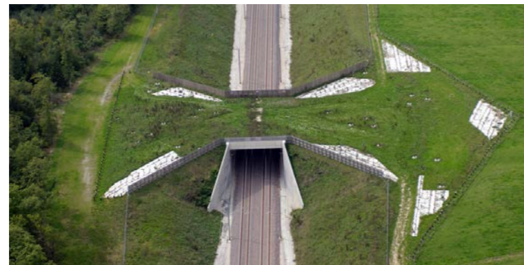
Exemple de passage grande faune (Source RFF)
