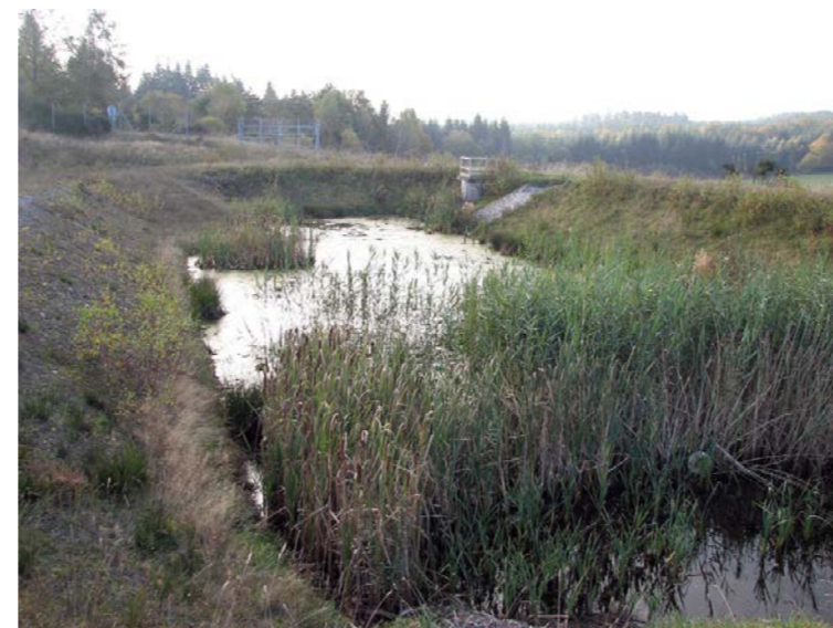
Bassin d'écroulement [Source : Egis]
