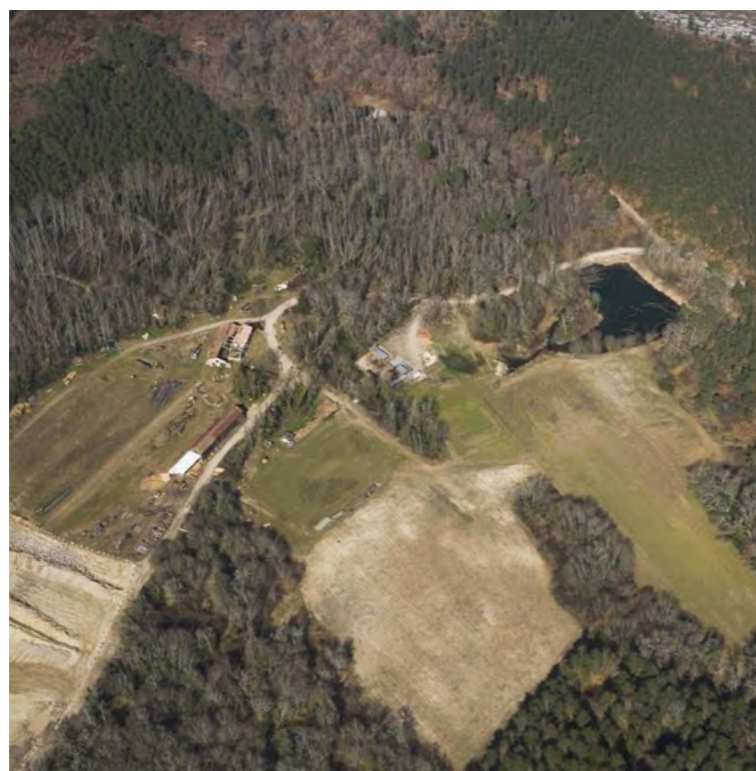
L'étang de la Gravière, réserve d'eau de défense contre les feux de forêts [Source : RFF]
