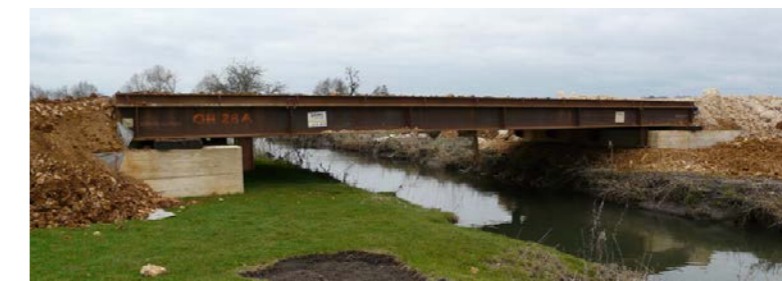
Exemple de pont provisoire préservant le lit mineur et les berges (Source : Egis)
