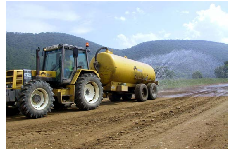
Arroseuse sur un chantier [Source : Egis]
