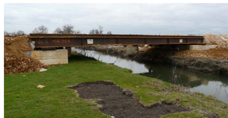
Exemple de pont provisoire préservant le lit mineur et les berges [Source : Egis]
