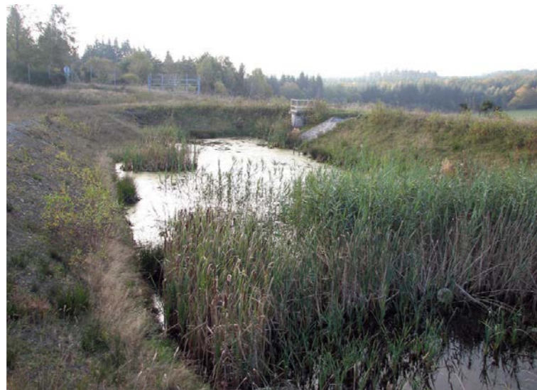
Bassin d'écrêtement (Source : Egis)
