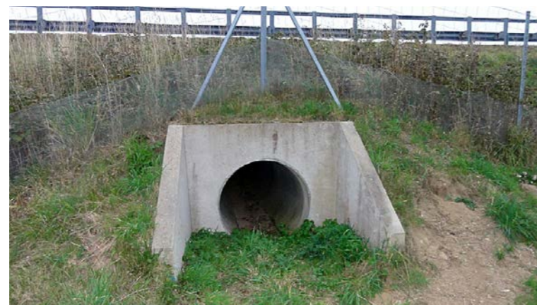
Ouvrage de type 3 (Source : Egis)
