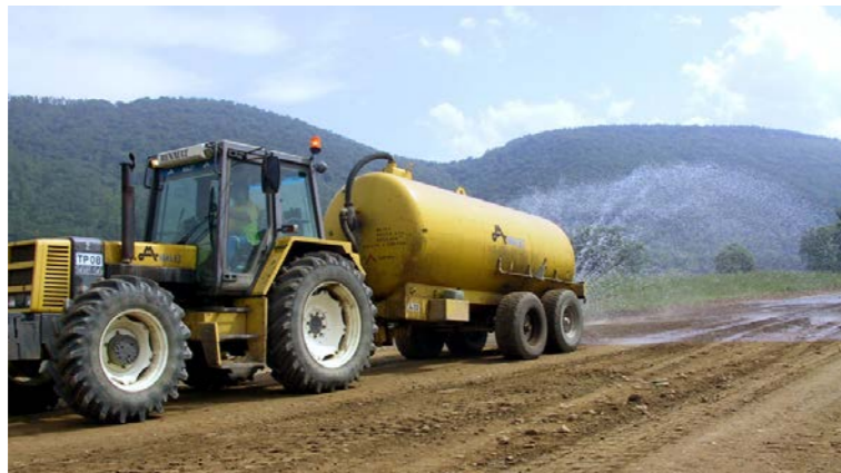
Arroseuse sur un chantier (Source : Egis)
