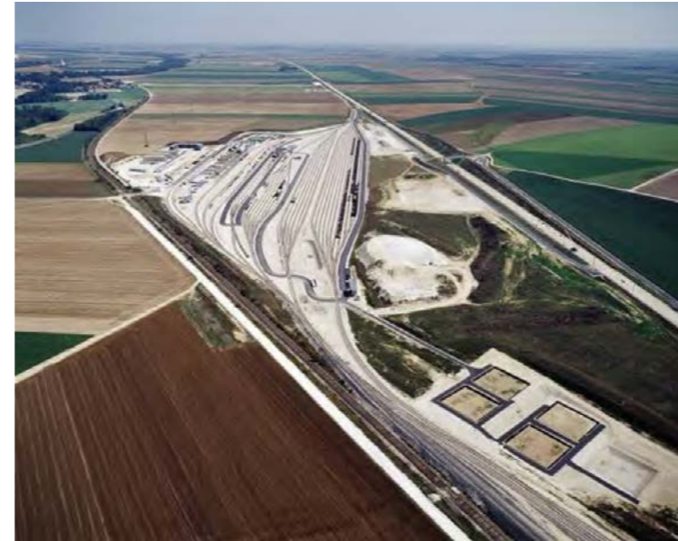
Base travaux de Vadenay - Saint-Hilaire-au-Temple sur la LGV Est européenne (source : RFF)
