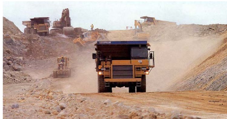
Envol de poussière créé par un Dumper (source EGIS)
