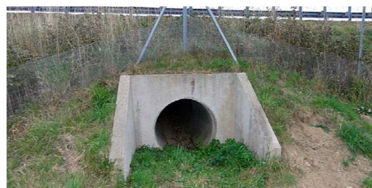
Ouvrage de type 3 (Source : Egis)
