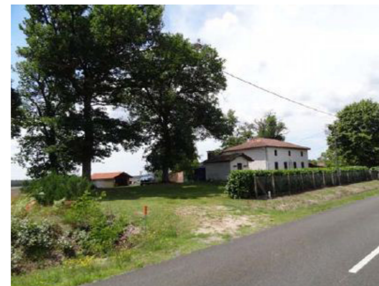
Bâti isolé le long de la RD42 à Pontonx-sur-l'Adour [Source : Egis, 2011]
