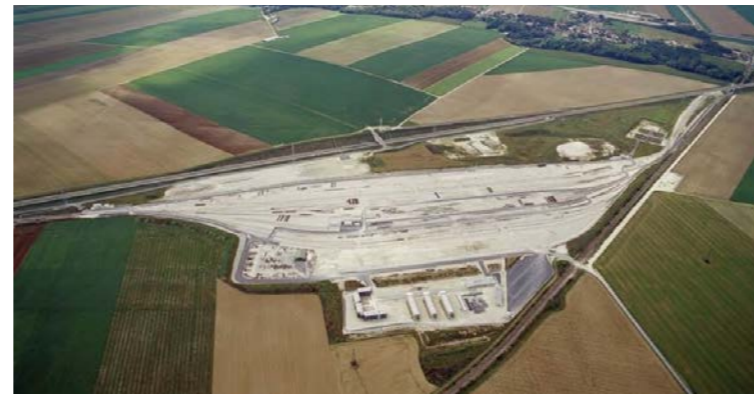
Vue aérienne de la Base Travaux de Saint-hilaire-au-Temple – LGV Est – [Source RFF, 2006]
