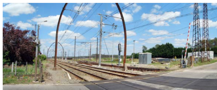
Voie ferrée existante à Laluque. [Source : Egis, 2010]
