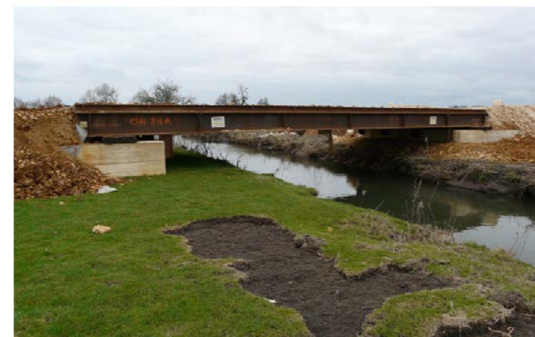
Exemple de pont provisoire préservant le lit mineur et les berges [Source : Egis]
