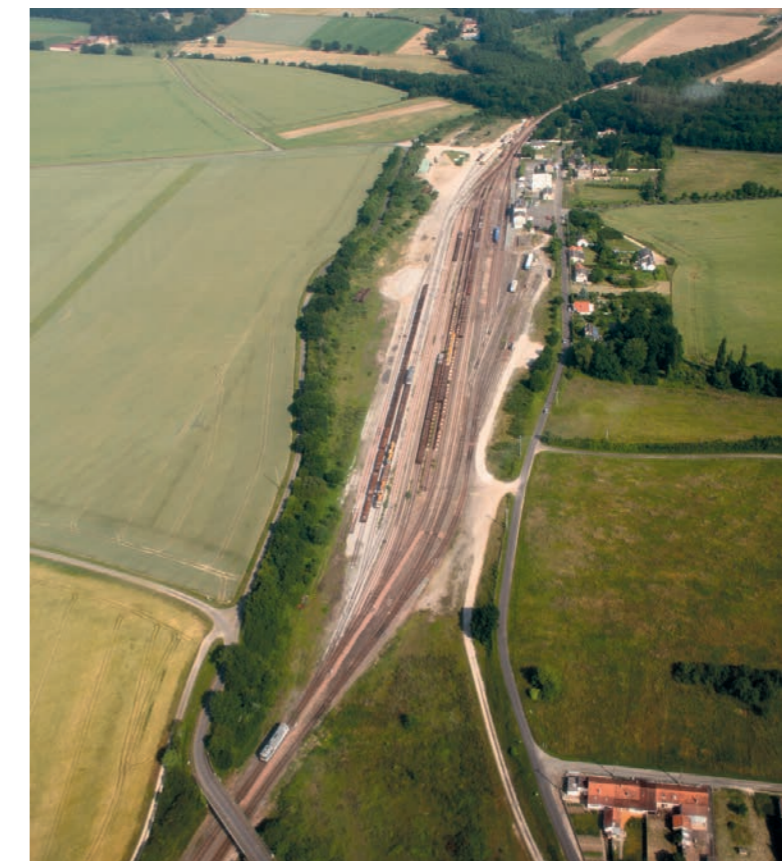
Base maintenance de Courtalain sur la LGV Atlantique (source : Inexia)
