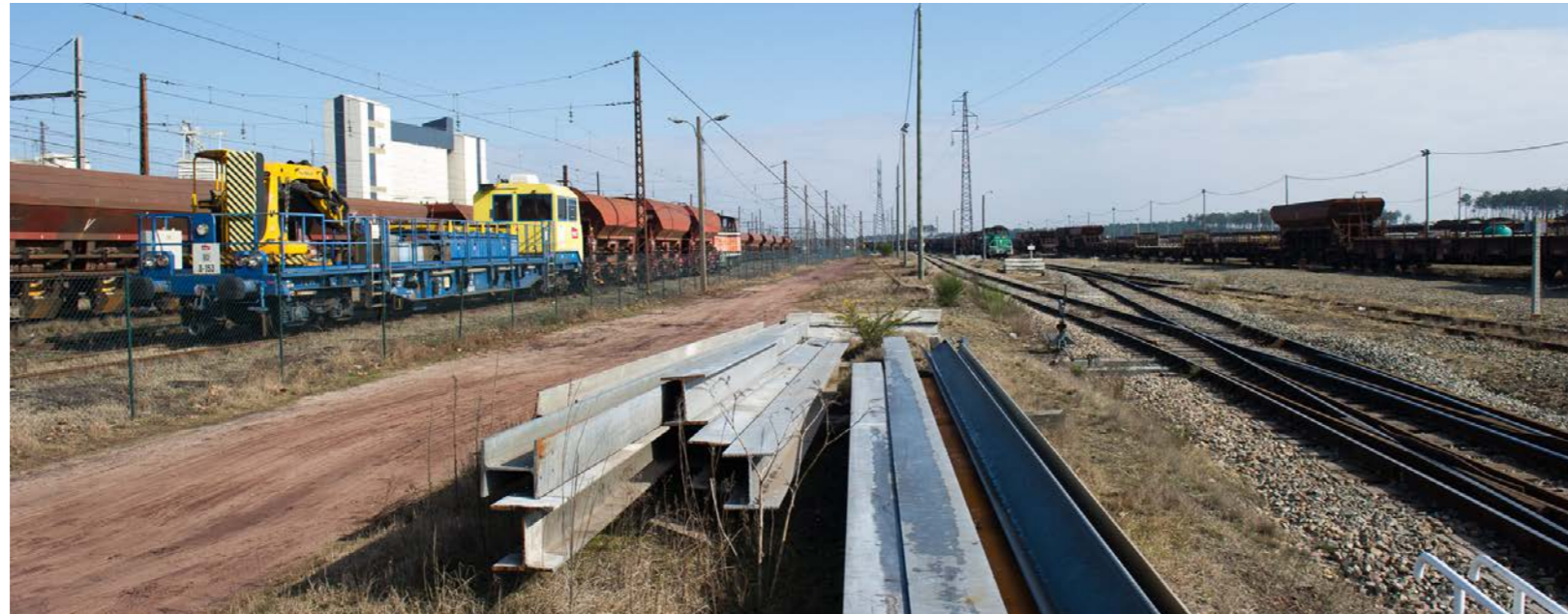
Trains de fret au niveau du SAS de Laluque (Source : RFF - Paul Robin)
