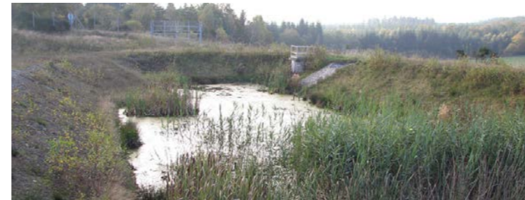
Exemple de bassin d'écêtement. (Source : Egis)
