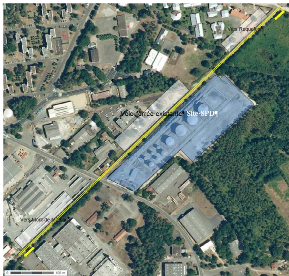
Vue aérienne du site SPD à Mont-de-Marsan (source Geoportail)
