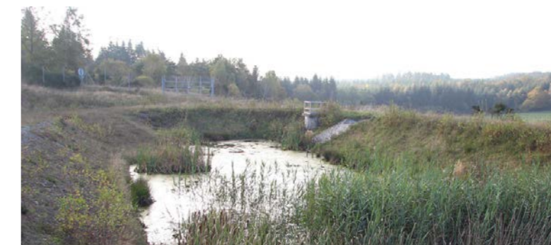
Bassin d'écroulement [Source : Egis]
