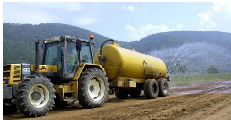
Arroseuse sur un chantier [Source : Egis]
