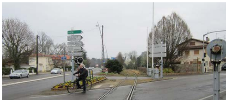
Passage à niveau n° 84 de Mont-de-Marsan. [Source CETE, 2012]
