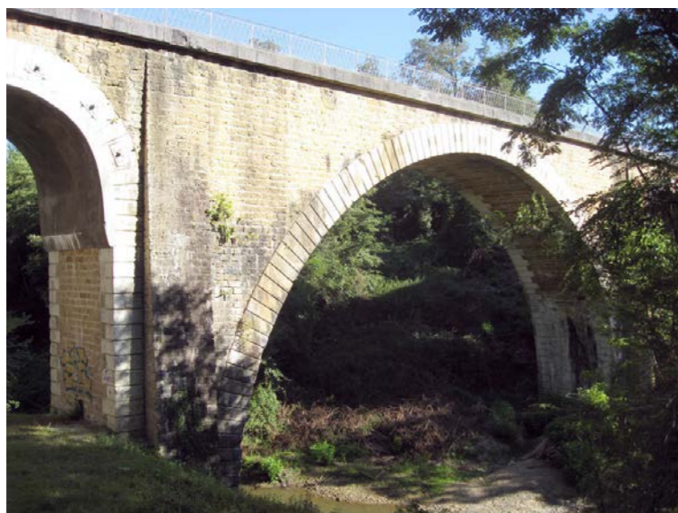
Ouvrage de franchissement du Midou. [Source Egis, 2012]
