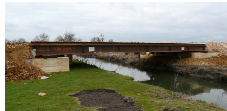
Exemple de pont provisoire préservant le lit mineur et les berges (Source : Egis)
