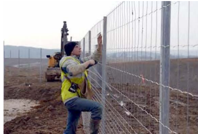
Clôtures temporaires autour des parcelles en élevage ou pâturée (Source : Egis)
