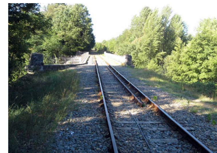
Ligne ferroviaire existante Mont-de-Marsan - Roquefort à Mont-de-Marsan, [Source Egis 2012]
