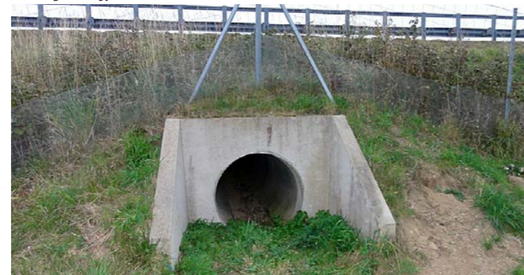
Ouvrage de type 3 [Source : Egis]
