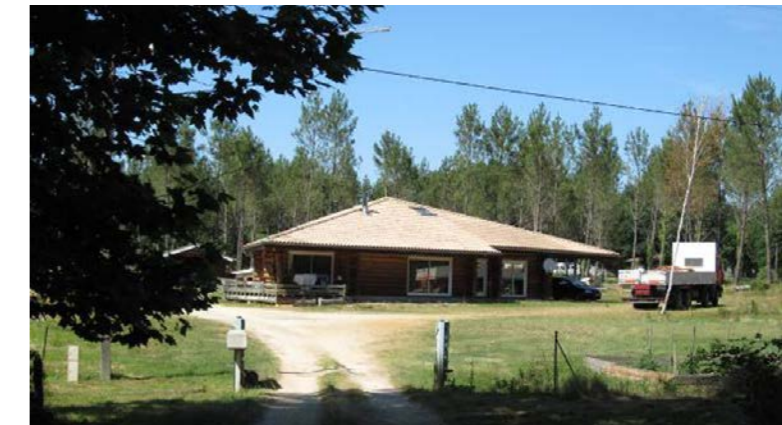
Fabrication de charpente du Hameau de Parentis [Source : Inexia SNC Lavalin Arcadis]
