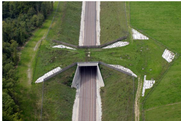
Exemple de passage grande faune
