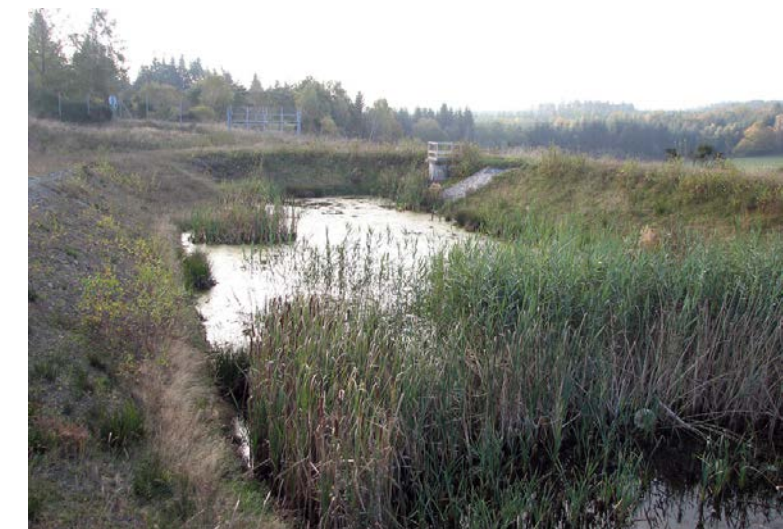
Exemple de bassin d'écroulement (Source : Egis)
