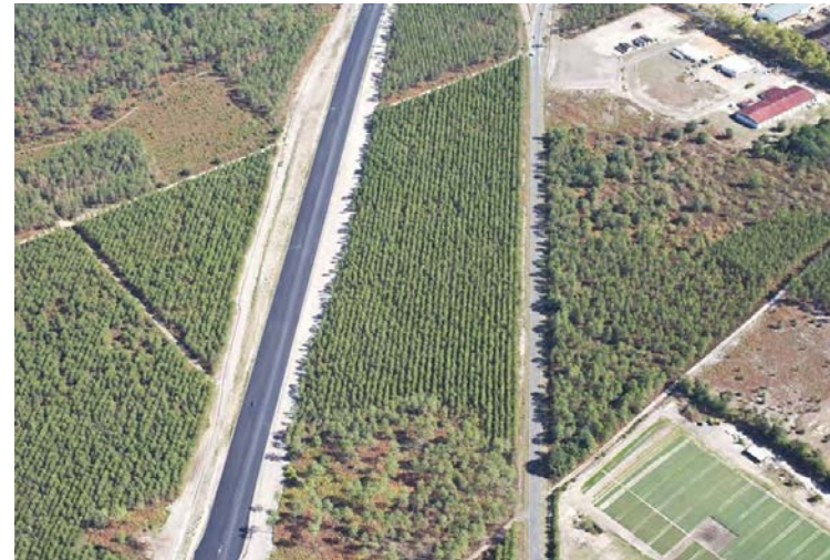
L'A65 (en construction) et la RD932, dont le tracé est parallèle au Nord de Roquefort (Source : RFF, 2010)
