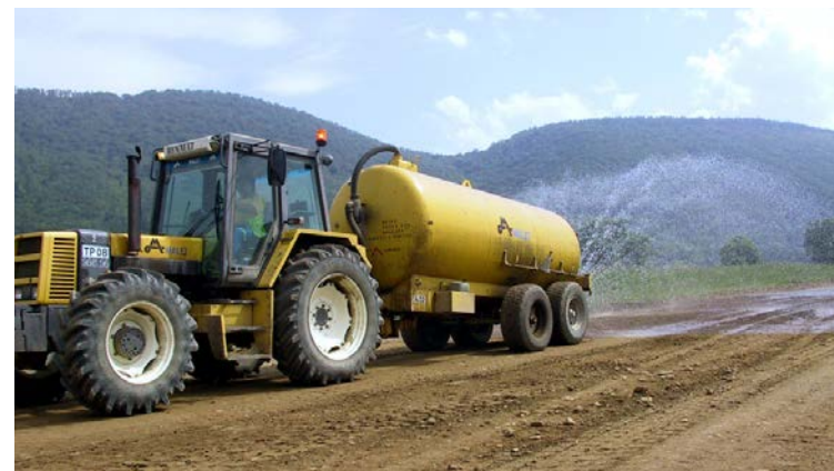
Arroseuse sur un chantier (Source : Egis)
