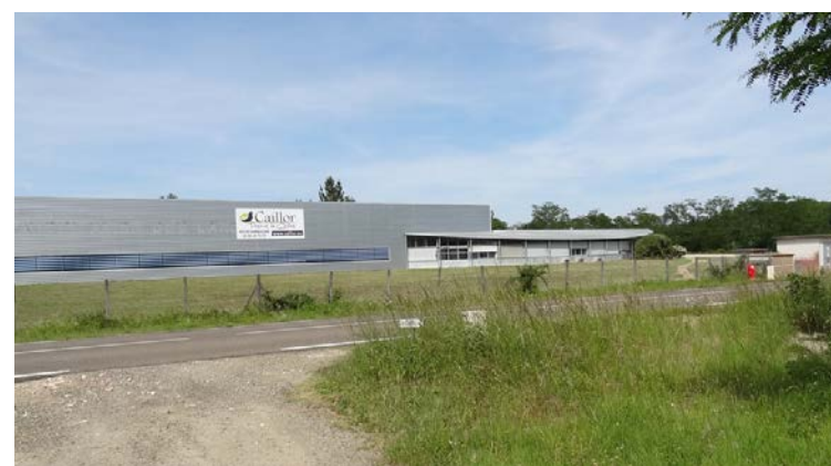
Société Caillor le long de la RD626, ZA de Picanton à Roquefort [Source : Egis 2012]
