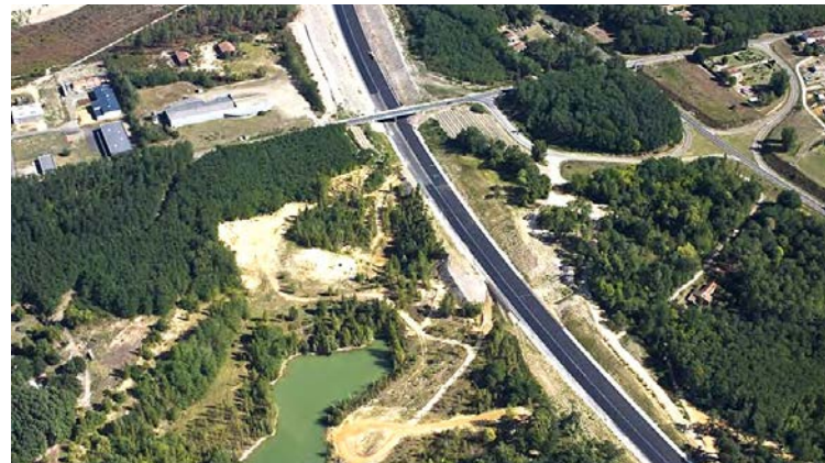
La zone de Picanton, l'A65 et son aire de services, le site de la carrière du Cros (Source : RFF 2010)
