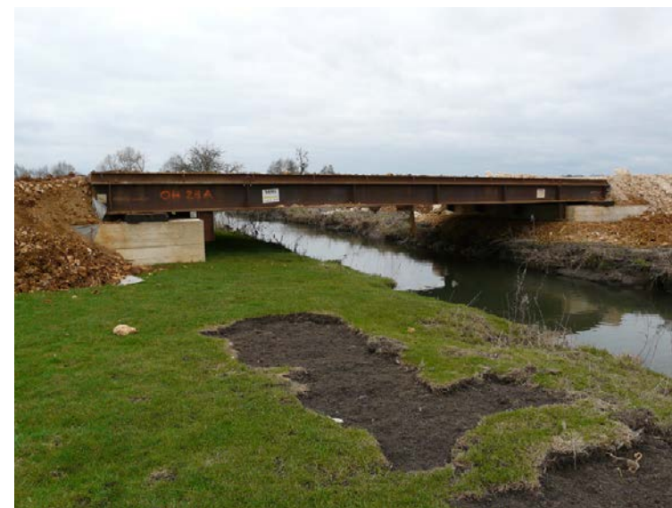
Exemple de pont provisoire préservant le lit mineur et les berges (Source : Egis)
