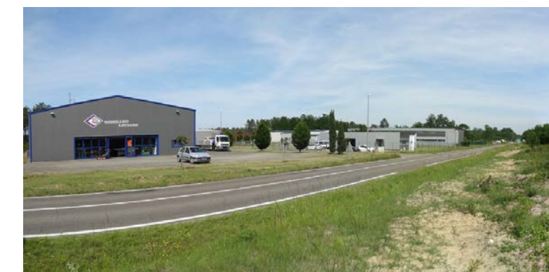
Zone d'activités de Picanton, le long de la RD626 à Roquefort (Source : Egis 2012)
