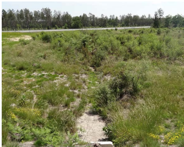
Lit asséché du ruisseau de Nabias, en amont de son franchissement par l'A65 [Source : Egis 2012]
