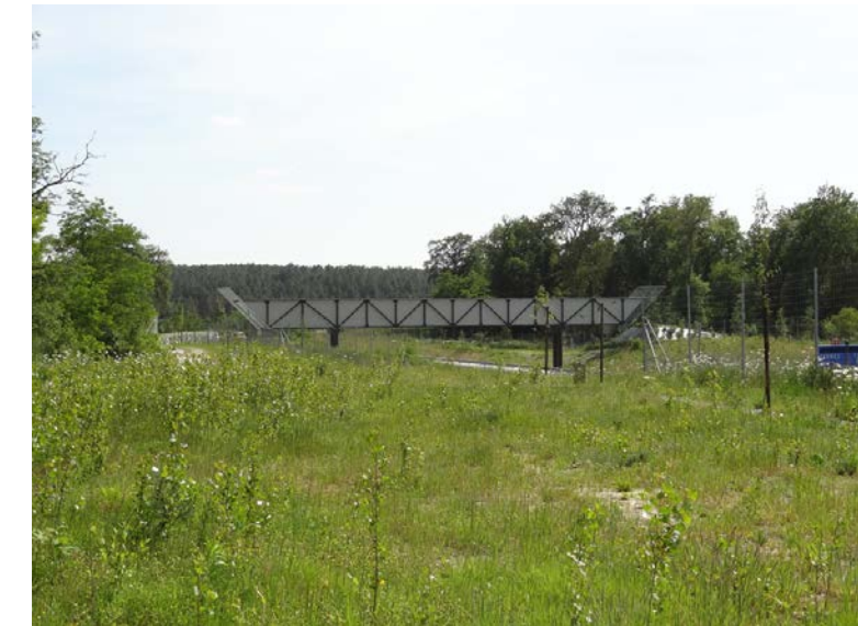
Ouvrage expérimental de rétablissement des couloirs de vol des chauves-souris au-dessus de l'A65 - Chiroptéroduc [Source : Egis 2012]
