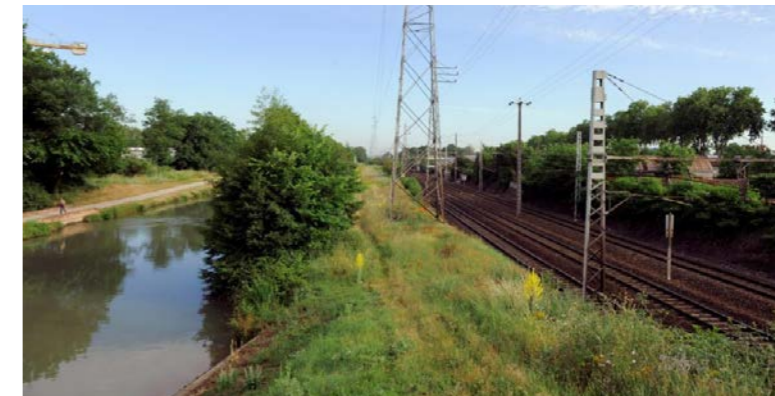
Canal latéral à la Garonne à proximité de la voie ferrée [source : RFF, 2012]
