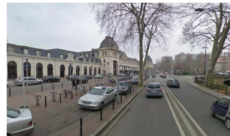
Gare de Toulouse-Matabiau [source : Google Maps, 2011]
