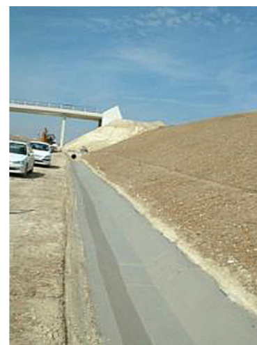
Fossé en terre revêtu en fond de déblai (source : SNCF)
