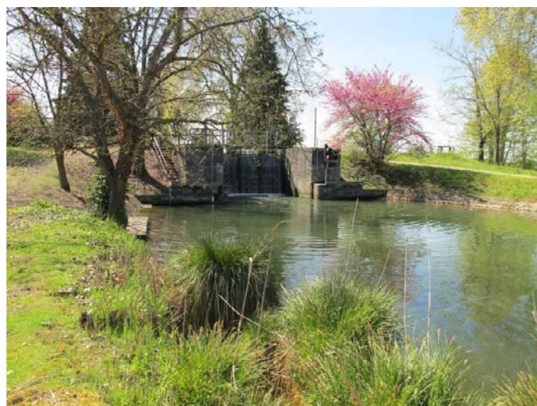
Écluse de Bordeneuve (source : SYSTRA, 2012)
