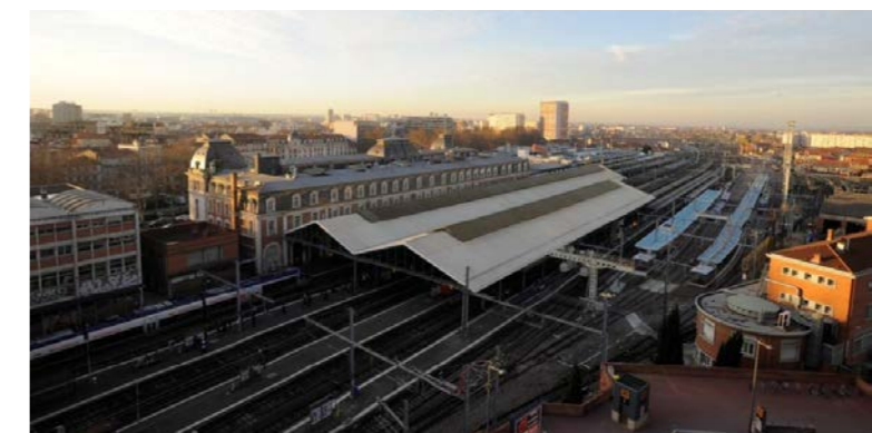
Gare de Toulouse-Matabiau [source : RFF, 2012]
