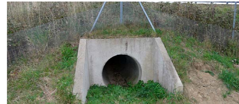
Ouvrage de type 3 (source : Egis, 2012)
