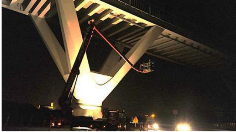
Exemple d'émissions lumineuses lors d'un contrôle de nuit sur un viaduc [source : LCV Rhin – Rhône]
