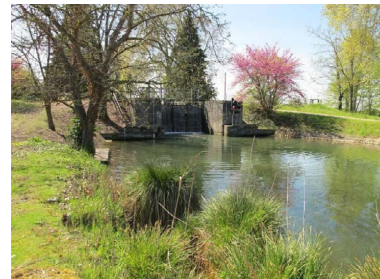
Écluse de Bordeneuve [source : SYSTRA, 2012]
