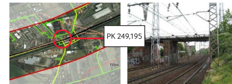
Ligne Haute Tension, interceptée au PK 249+195 à Fenouillet (Source : Inexia, 2010)
