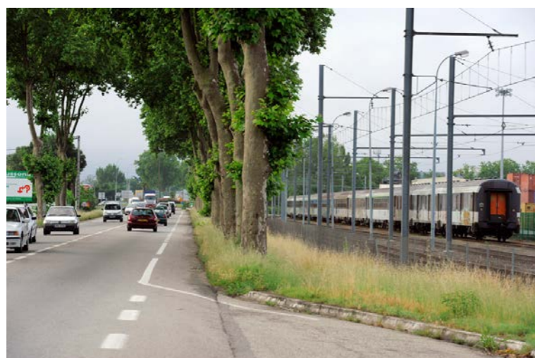
Voie ferrée et RD820 (source : RFF, 2012)
