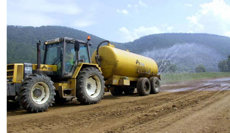
Arroseuse sur un chantier [Source : Egis]
