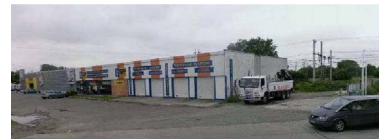
Bâtiments commerciaux en sortie de Toulouse (source : SYSTRA, 2012)
