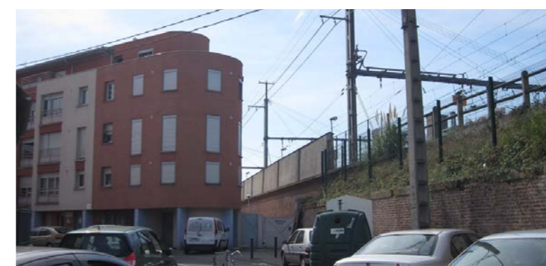
Bâtiment HLM sur Toulouse (source : SYSTRA, 2012)
