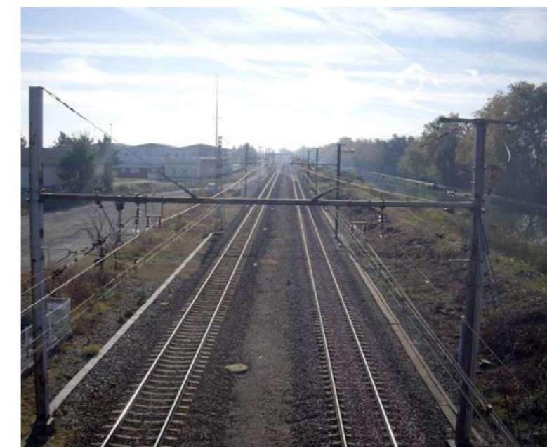
Ligne existante du secteur géographique n° 12 avec le Canal latéral à la Garonne à l'Ouest et une zone d'activité à l'Est [source : SYSTRA, 2012] Vue en direction du Sud
