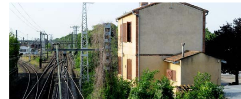
Maison éclusière de Lespinasse [source : RFF, 2012]
