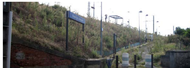
Halte Route de Launaguet [source : SYSTRA, 2012]
