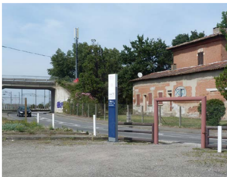
Intermodalité de la halte de Fenouillet [source : SYSTRA, 2012]
