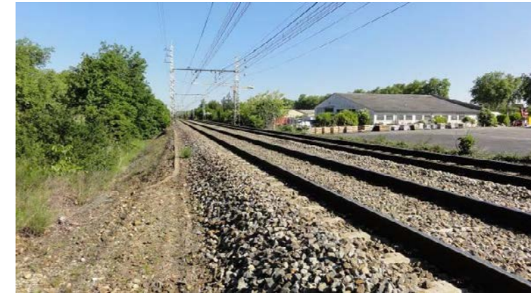
Abords de la voie ferrée très attractifs pour les reptiles [source : Biotope]
