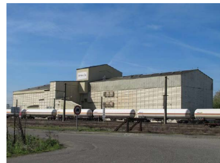
Silo « Arterris » (source : SYSTRA, 2012)
