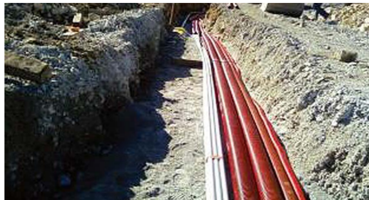
Enfouissement de réseau électrique (source : ville-chaville.fr)
