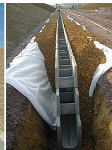
Pose d'un fossé en béton préfabriqué à barbacanes en fond de déblai (source : SNCF)
