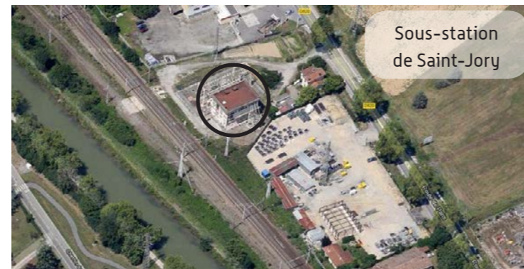
Vue aérienne de la sous-station de Saint-Jory (Source : Google Maps)
