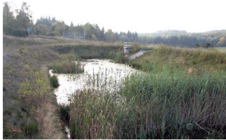
Bassin d'écroulement (Egis, 2012)
