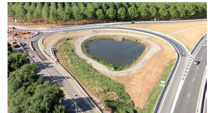
Bassin de rétention (source : La Dépêche)
