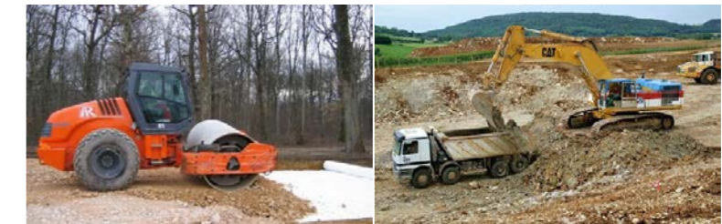
Engins de chantier pour compactage à gauche [source: SYSTRA] et déchargement à droite [source: LCV Rhin - Rhône]
