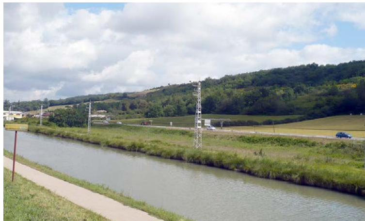
Canal latéral à la Garonne longé d'une piste cyclable sur la commune de Saint-Rustice (Source : Egis)
