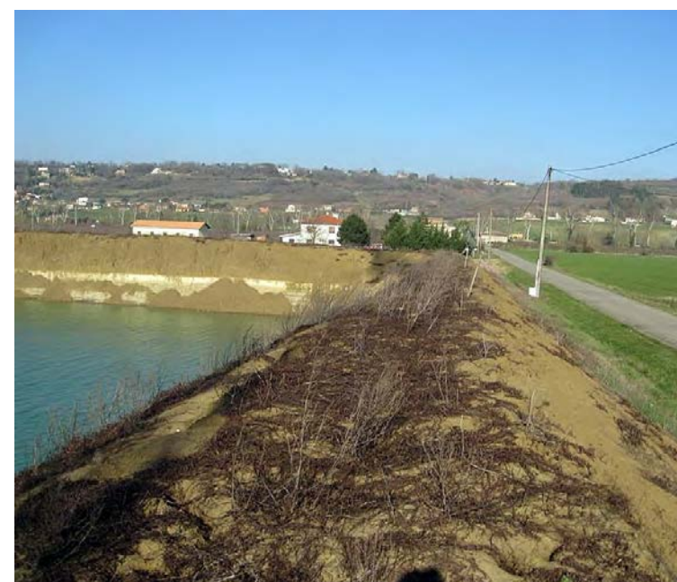
Merlon de la gravière MGM à Saint-Rustice [Source : Egis, 2013]
