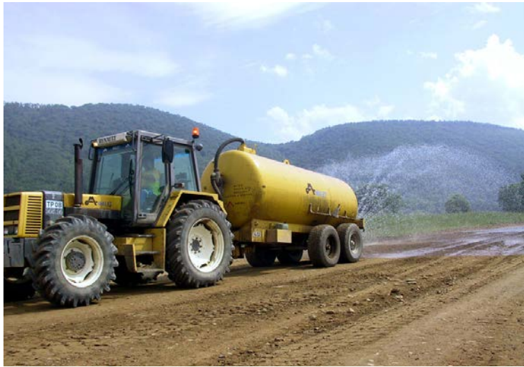
Arroseuse sur un chantier (Source : Egis)
