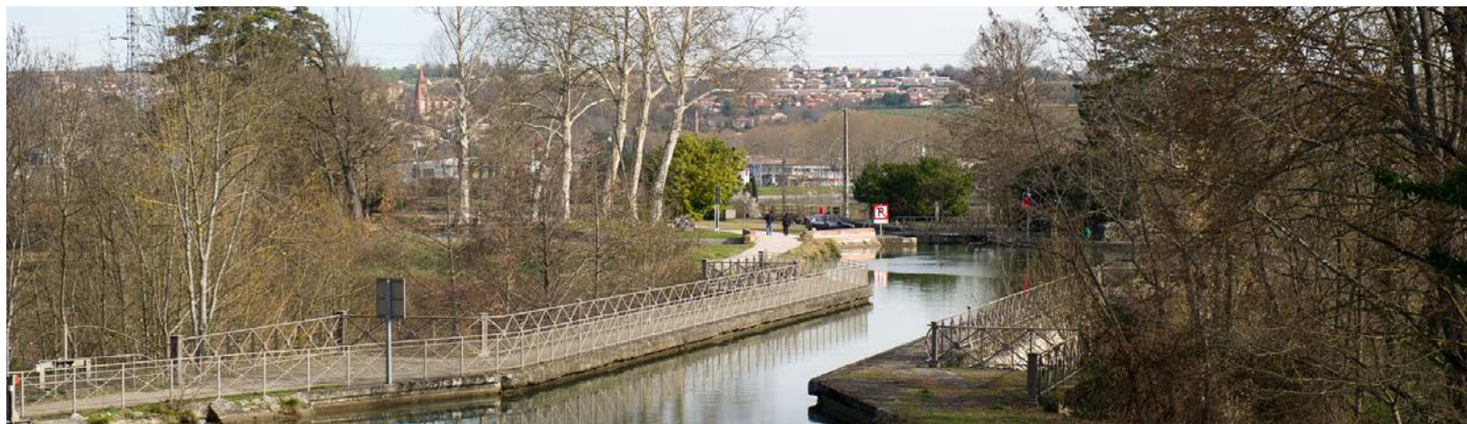
Canal latéral à la Garonne à Saint-Jory [Source : RFF - Paul Robin]
