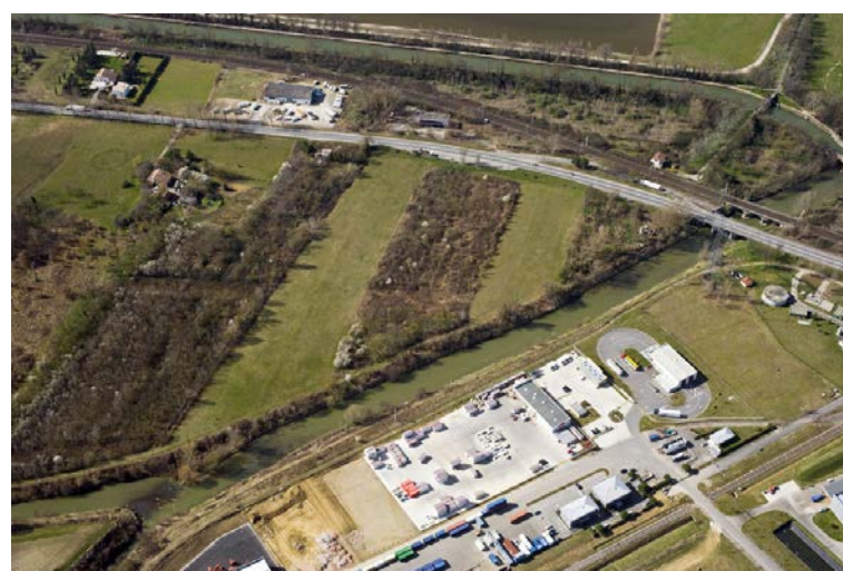
L'Hers Mort et sa confluence avec le Girou en limite de communes entre Saint-Jory, Saint-Sauveur et Castelnau-d'Estrétefonds [Source : Réseau Ferré de France, 2012]
