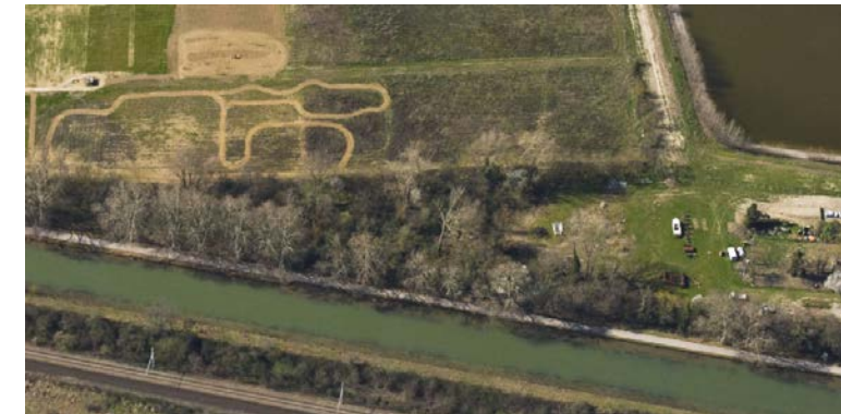
Zone humide au Sud-Est du lac de Capy en bordure de la ripisylve du canal latéral à la Garonne (Source : Réseau Ferré de France)
