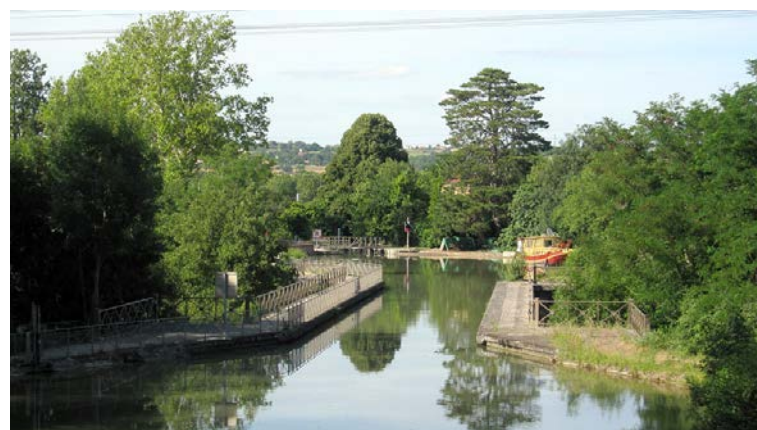
Écluse du canal latéral à la Garonne sur la commune de Castelnaud-d'Estrétefonds [Source : Groupement Inexia – SNC Lavalin – Arcadis]
