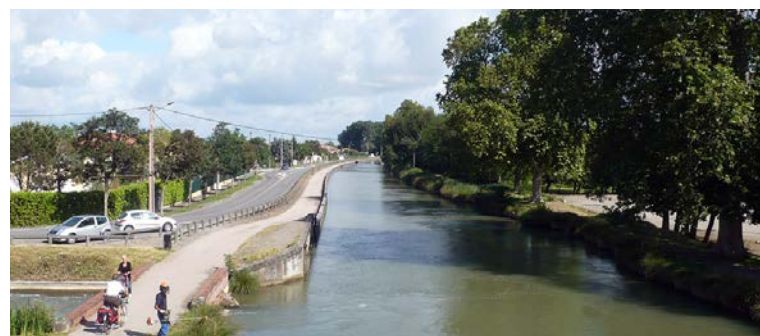
Le canal latéral à la Garonne à Saint-Jory [Source : Egis]
