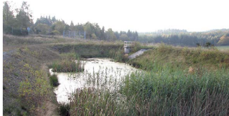
Bassin d'écrêtement. (Source : Egis)
