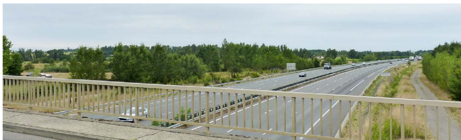
Franchissement de l'A62 au niveau de Campsas [Source : Soberco, 2010]
