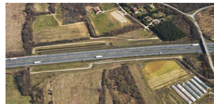
L'autoroute A62 à Campsas [Source : Réseau Ferré de France, 2012]
