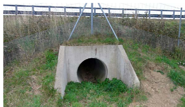
Ouvrage de type 3 [Source : Egis]
