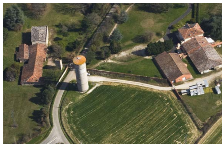
Le château d'eau du Pastenc à Bressols [Source Réseau Ferré de France 2012]
