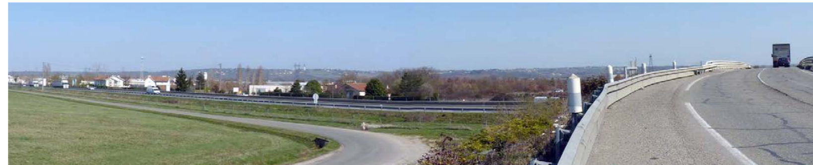
Autoroute A20, un enjeu de franchissement avec de nombreuses covisibilités [Source : Soberco, 2010]
