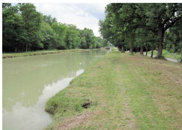
Le Canal de Montech [Source : OGE]
