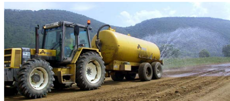
Arroseuse sur un chantier (Source : Egis)
