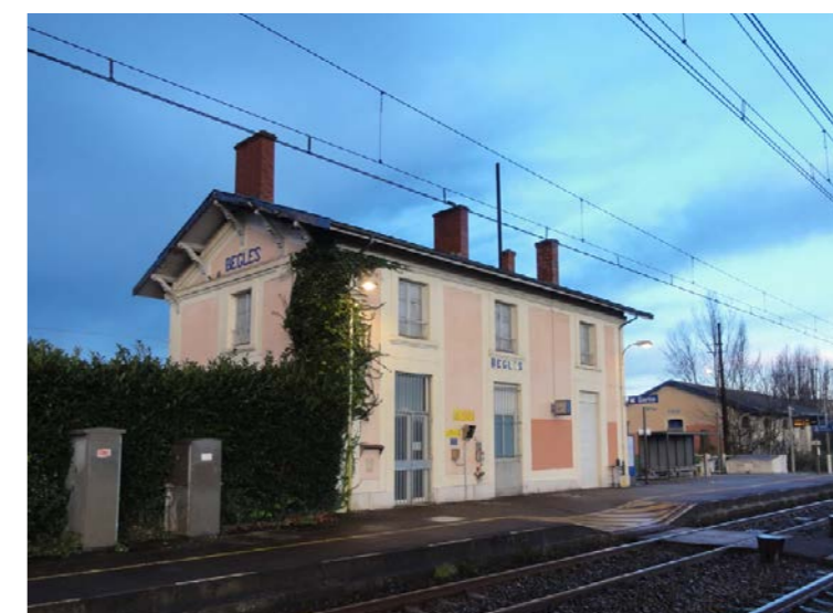
La gare de Bègles [Source : Egis, 2013]
