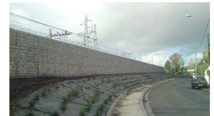
Exemple d'écran acoustique en gabions de pierres (Source : Egis, 2013)
