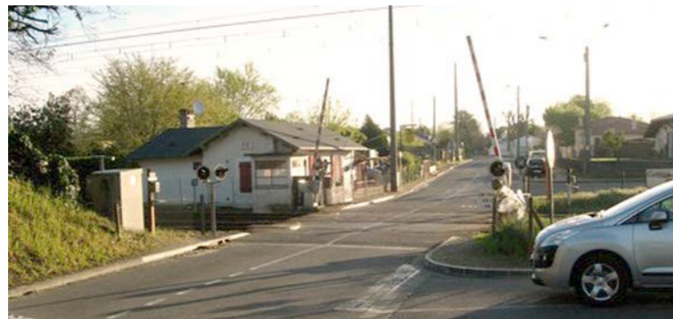
Passage à niveau n° 10 à Cadaujac [Source : CETE Sud-Ouest]
