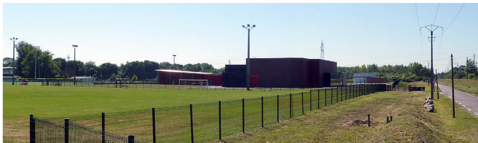
Vue sur l'équipement sportif du domaine de la Junca et la voie ferrée existante entre Cadaujac et Villenave d'Ornon [Source : Soberco, 2010]
