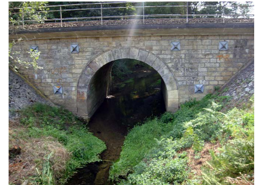
Ouvrage de franchissement du ruisseau du Saucats par la ligne ferroviaire Bordeaux-Sète [Source : Egis, 2012]
