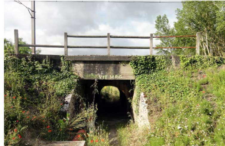
Passage agricole sous la ligne ferroviaire à Saint-Médard-d'Eyrans servant aussi aux randonneurs et cyclistes [Source : Egis, 2012]
