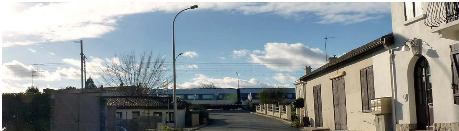
Vue sur la voie ferrée existante et le passage à niveau de la RD214 au lieu-dit « Baron » à Saint-Médard-d'Eyrans [Source : Soberco, 2010]
