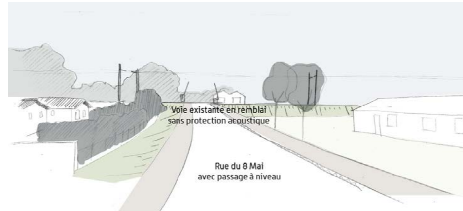
Passage à niveau de la rue du 8 Mai : état existant [Source : Egis, 2013]
