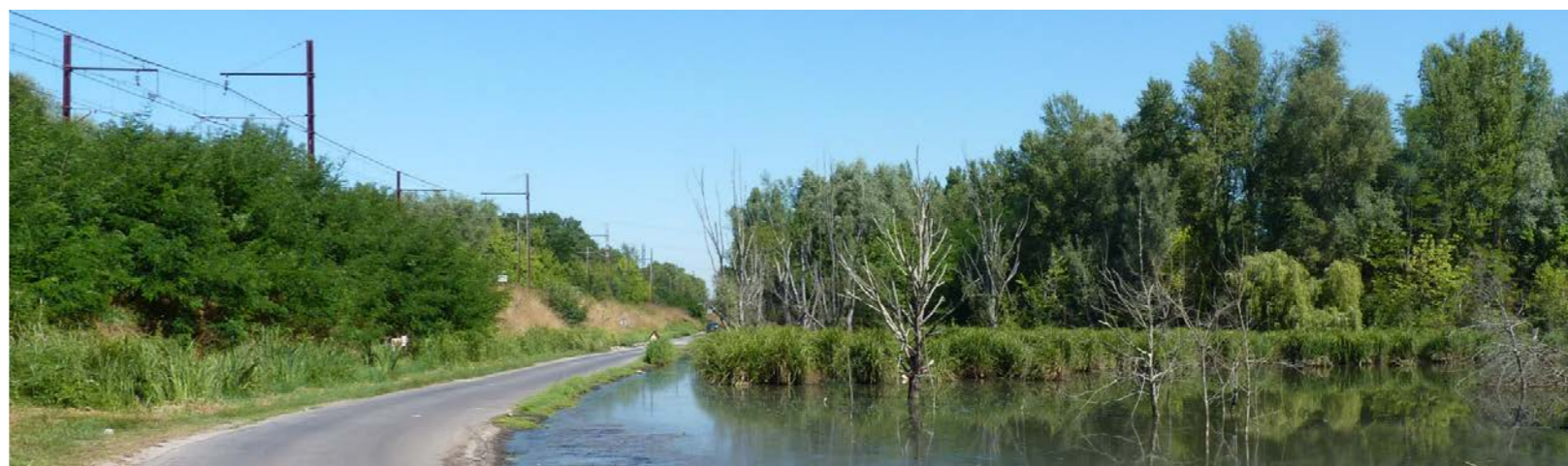
Vue sur la zone inondable du ruisseau de l'Eau Blanche et la voie ferrée existante à Cadaujac [Source : Soberco, 2010]
