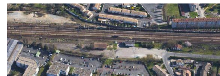
Gare de Bègles (Source : RFF, 2012)
