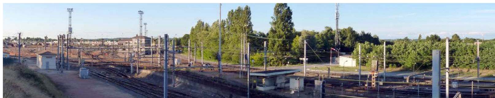
Vue de la gare de triage d'Hourcade depuis le Chemin du Pas de la Côte sur la commune de Villenave-d'Ornon [Source : Egis, 2012]
