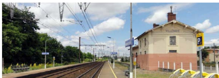
Halte de Villenave-d'Ornon [Source : Egis, 2012]
