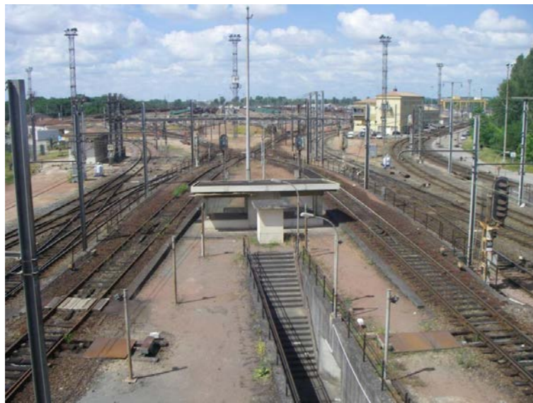
Gare de triage d'Hourcade [Source : Egis 2012]
