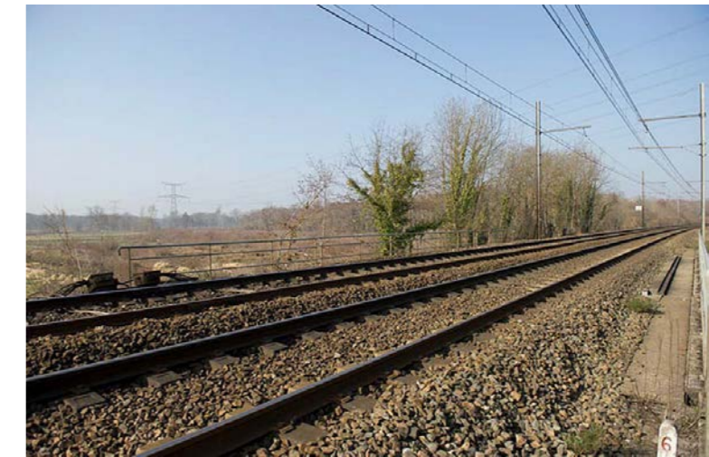
Ligne ferroviaire existante à Saint-Médard d'Eyrans [Source RFF 2013]
