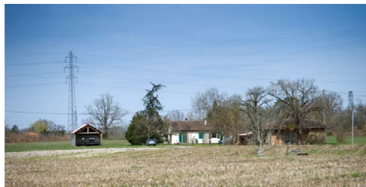
Habitation à Bressols [Source RFF 2013]
