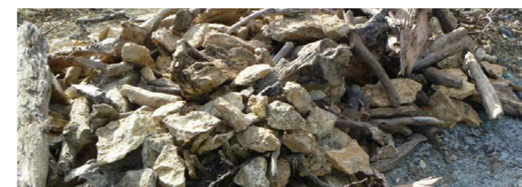
Hibernaculum en cours de construction (Source : Écosphère)
