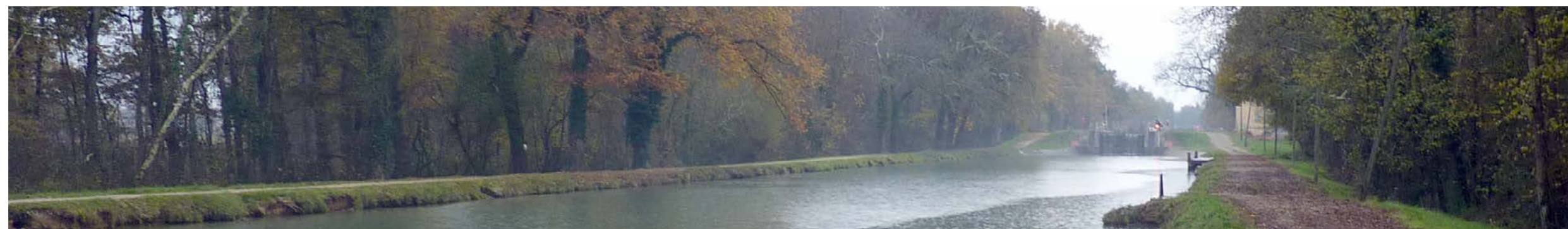
Le canal de Montech [Source RFF]
