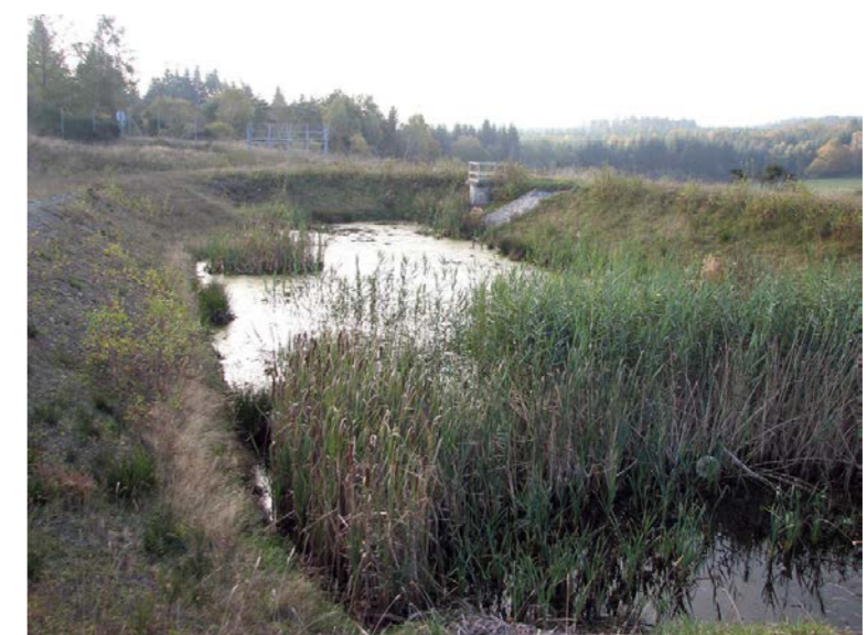
Bassin d'écroulement (Source : Egis)
