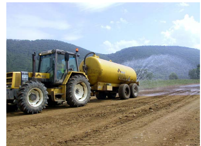
Arroseuse sur un chantier (Source : Egis)
