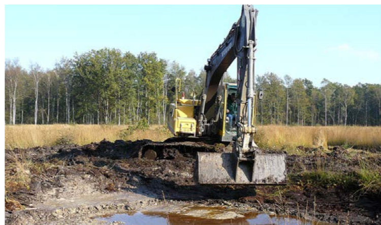
Travaux de terrassement du profil des berges d'une mare (Source : Écosphère)
