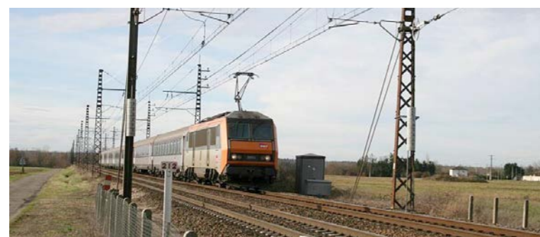
Ligne existante Bordeaux-Sète [Source Egis]
