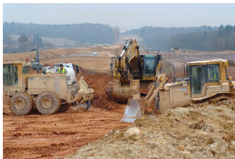
Travaux de terrassement sur un chantier [Source RFF]
