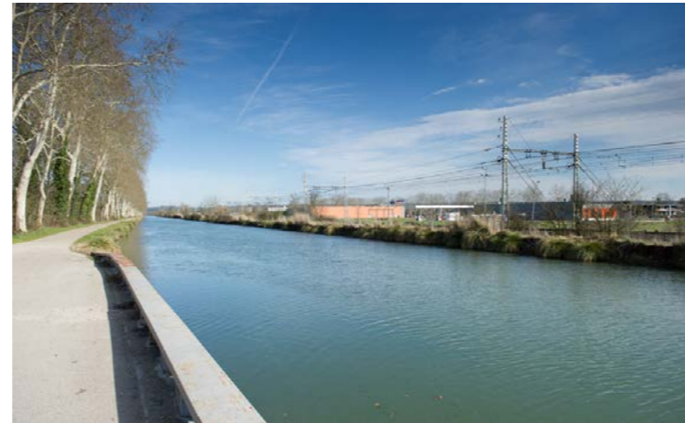
Canal latéral à la Garonne à Saint-Jory [Source RFF 2013]
