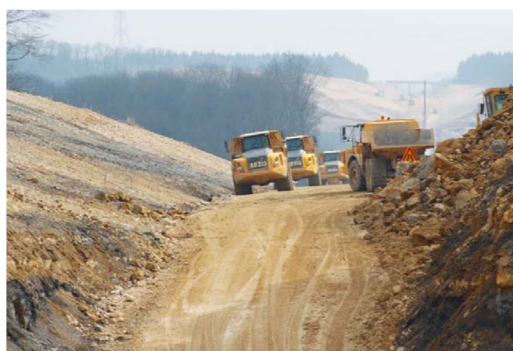
Dumpers sur un chantier [Source RFF]
