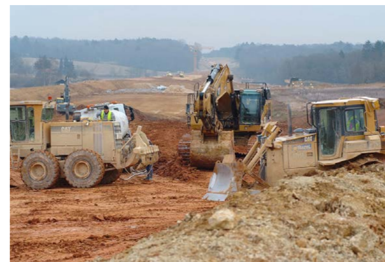
Chantier de terrassement (Source RFF)
