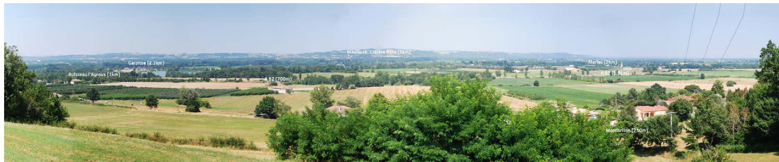
Insertion de la ligne nouvelle à Saint-Michel (82) – État initial et État projet (Source Egis)
