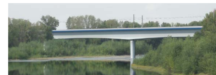
Exemple d'ouvrage de type 1 [Source : Egis]
