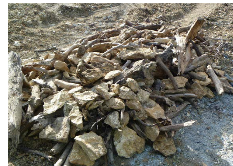
Hibernaculum en cours de construction [Source : Écosphère]
