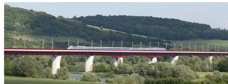
Exemple de viaduc enjambant le lit mineur et les berges (Source : RFF)
