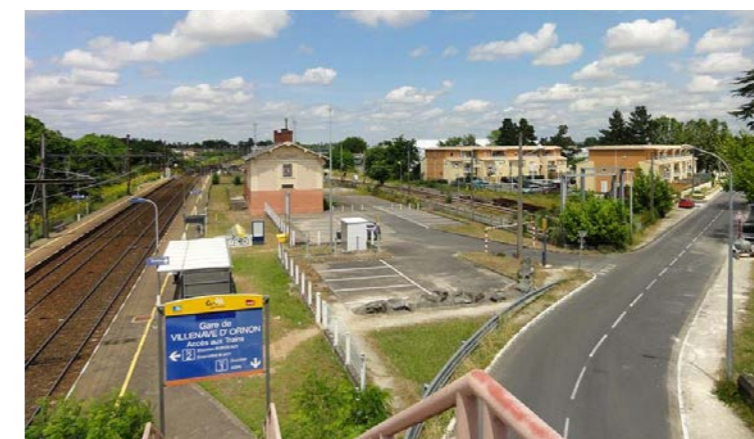
Halte de Villenave-d'Ornon [Source : Egis, 2012]
