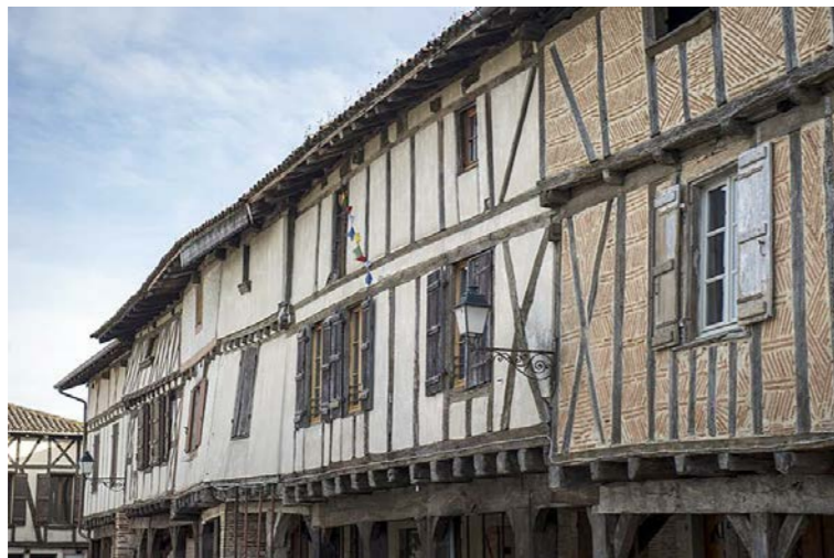
Patrimoine local en Tarn-et-Garonne (Source RFF)
