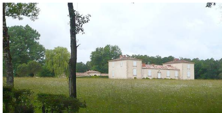
Le château le Boscage [Source : Egis, 2012]
