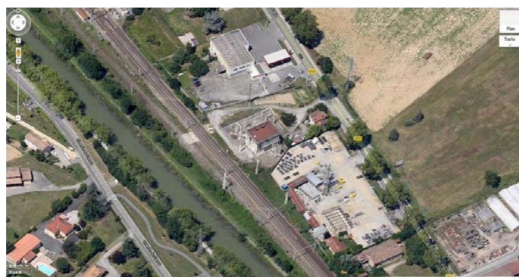
Vue aérienne de la sous-station de Saint-Jory [Source : Googlemap, 2012]
