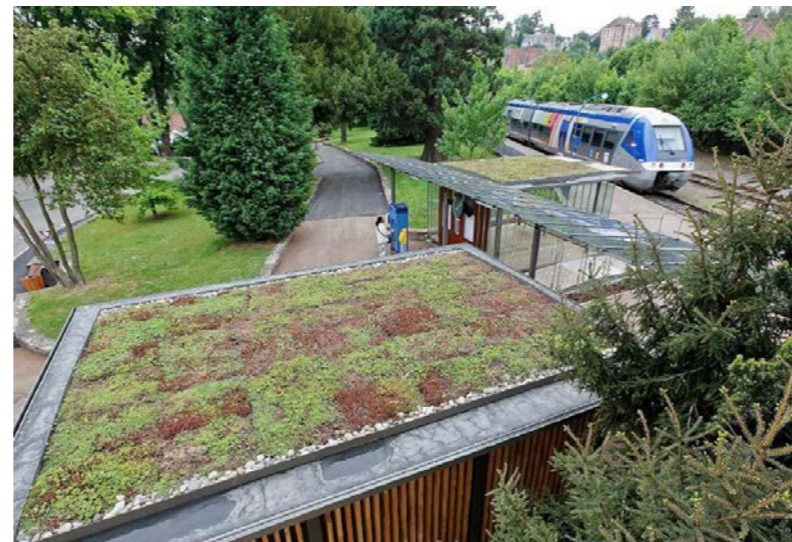
Halte ferroviaire de Niederbronn-les-Bains en Alsace (Source : SNCF)
