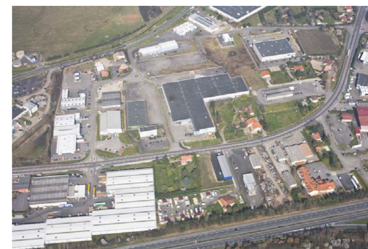
Zone d'activités du Triel à proximité de la nouvelle gare d'Agen, commune de Le Passage [Source Fit conseil]
