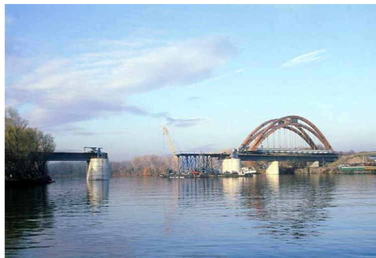
Travaux de construction d'un viaduc [Source : RFF]
