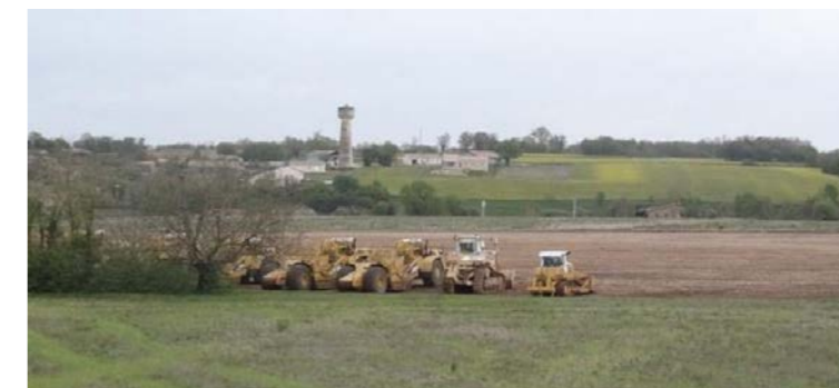
Engins de chantier en stationnement [Source : Egis, 2012]
