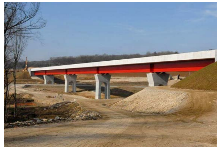
Réalisation d'ouvrages d'art [Source : RFF]
