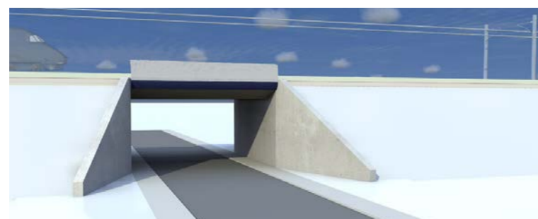
Pont-rail : PRA (Source : Egis, 2013)
