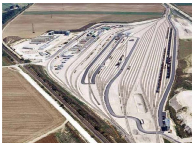
Base travaux de Vadenay Saint-Hilaire au Temple (51) sur la LGV Est européenne (Source : RFF)
