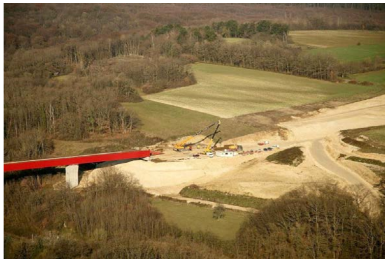
Travaux à proximité d'espaces boisés [Source : RFF]
