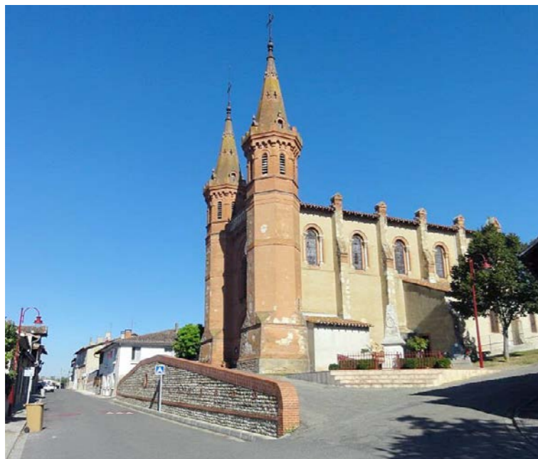
Église de Saint-Rustice, monument historique inscrit sur la commune de Saint-Rustice [Source : Egis, 2012]
