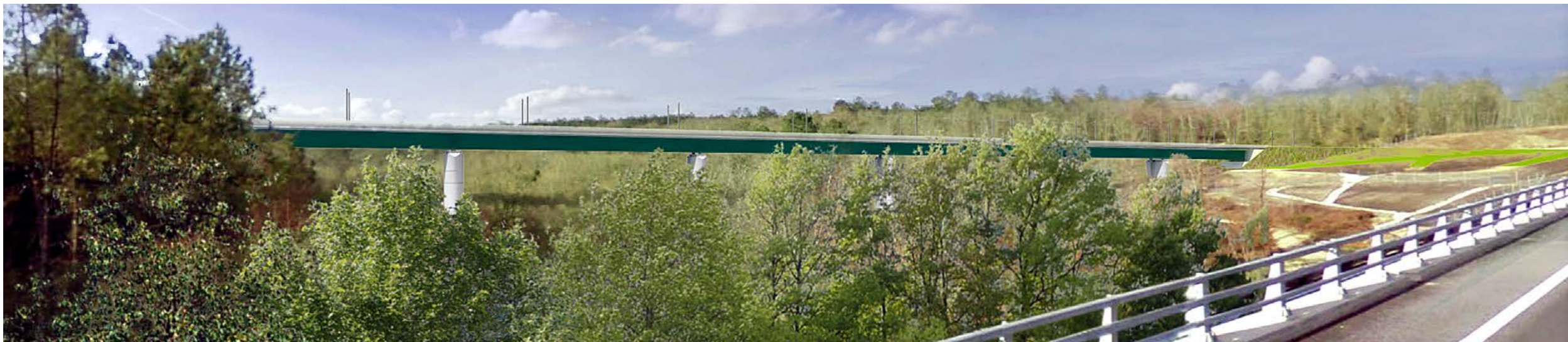
Franchissement de la Douze dans les Landes. (Source : Egis, 2013)
