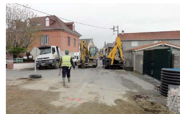
Travaux à proximité de zones urbanisées [Source : Egis, 2012]
