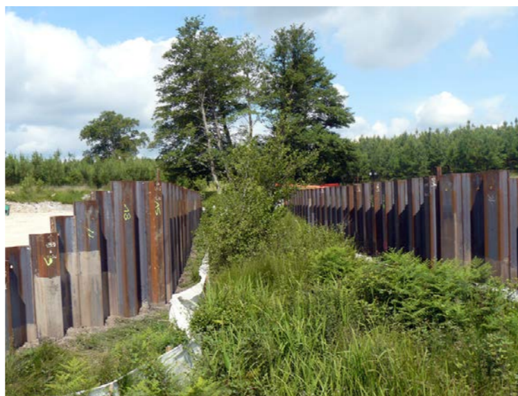
Ouvrage adapté à la préservation d'une partie des berges lors de la phase travaux (Source : Ecosphère)
