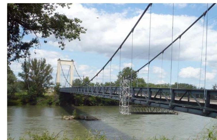
Franchissement de la Garonne à Belleperche [Source : Egis, 2012]
