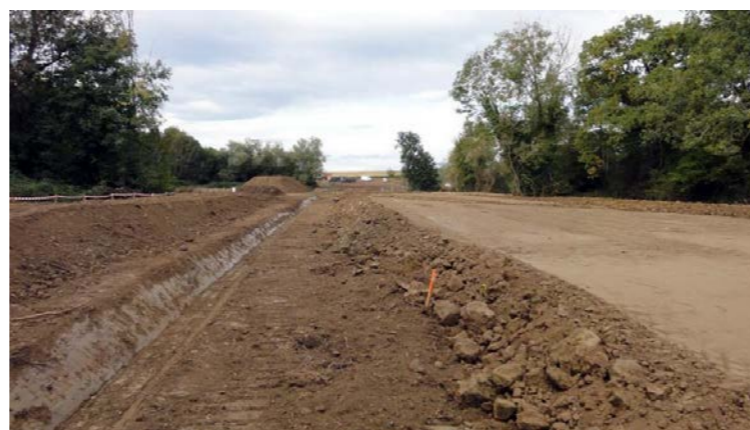
Fossé provisoire [Source : Egis]
