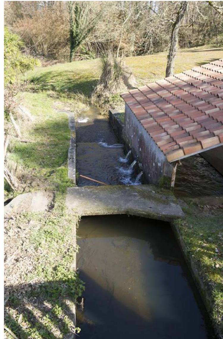
Lavoir dans le Nord des Landes (source RFF)
