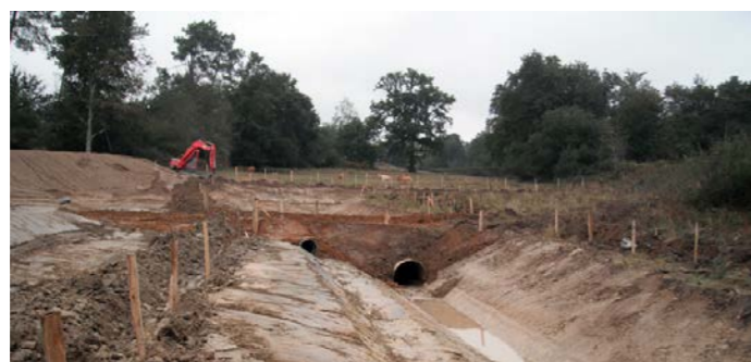
Dérivation en cours de construction avec la buse sèche [C. Bout - GREGE]
