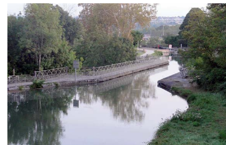
Prise d'eau destinée à l'AEP dans le canal latéral à la Garonne sur la commune de Saint-Jory [Source : Egis, 2012]
