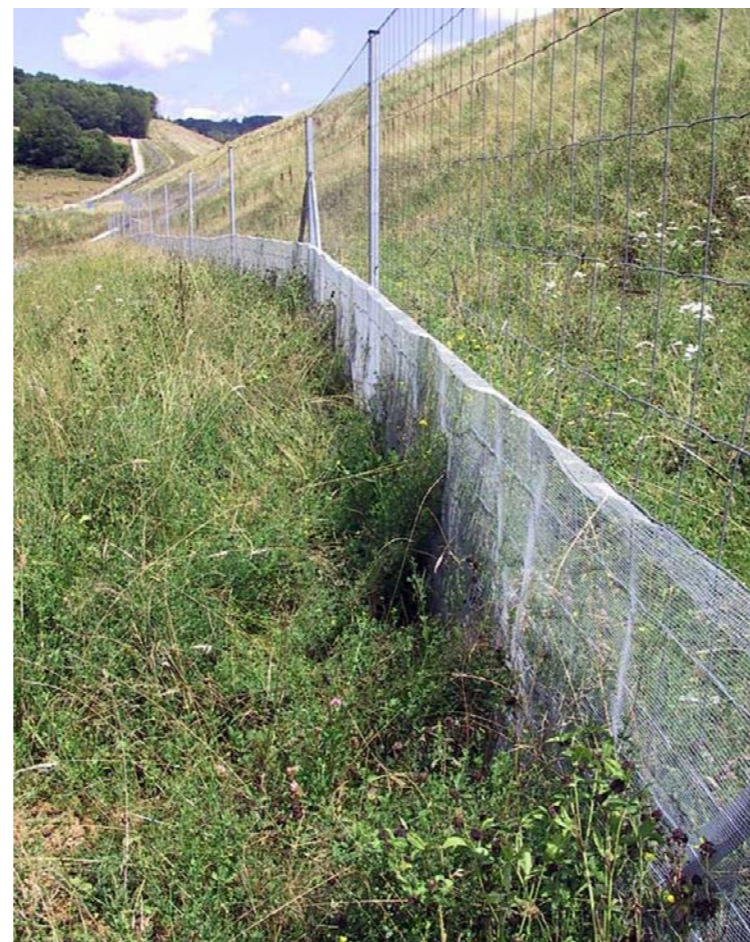
Clôture à maille fine interdisant l'accès aux amphibiens (Source : Egis)
