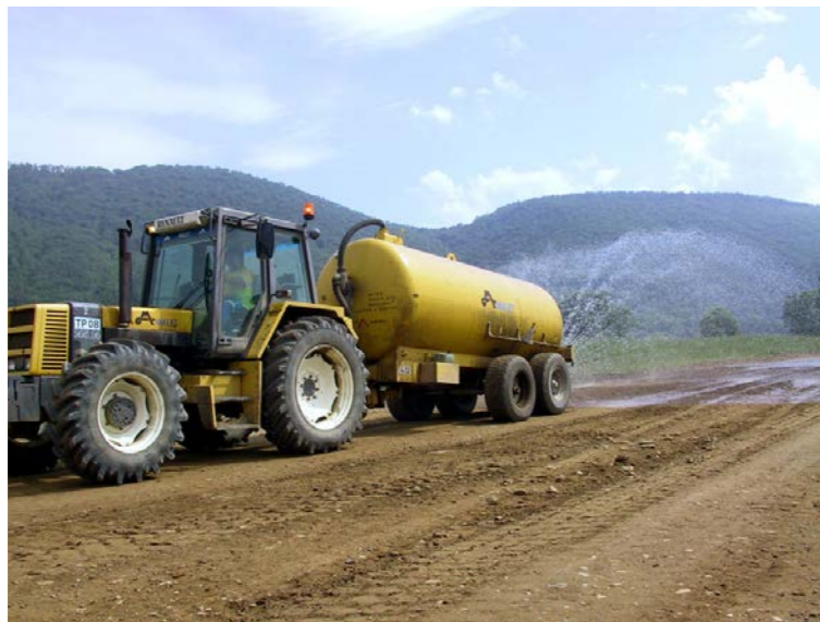
Arrosage des piste pour limiter les envols de poussières (Source : Egis)
