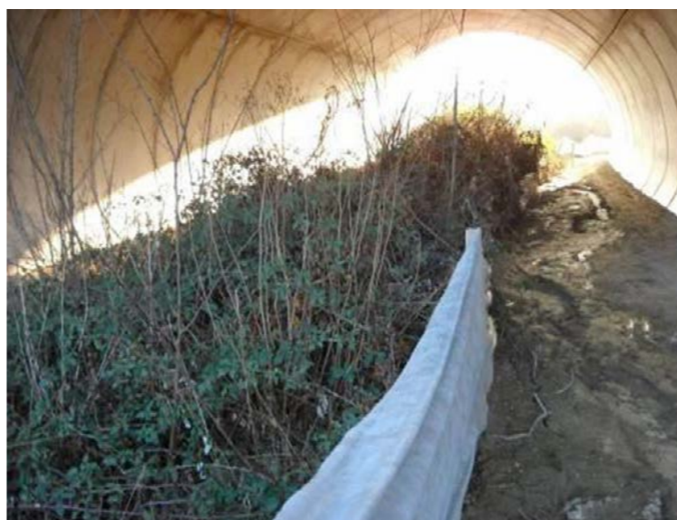
Ouvrage assurant la transparence écologique pour la Musaraigne aquatique 1 an après travaux (Source : Ecosphère)
