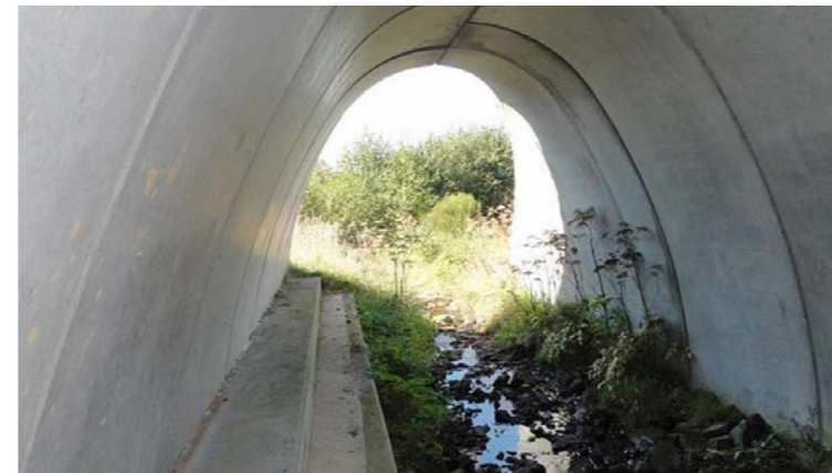
Exemple d'ouvrage de type 2 (Source Egis, 2011)
