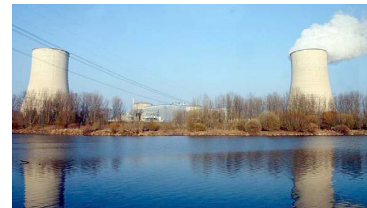
Centrale nucléaire de Golfech [Source internet]
