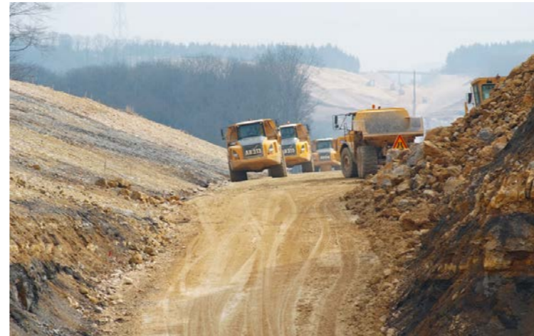
Travaux de génie civil : terrassement [source RFF]
