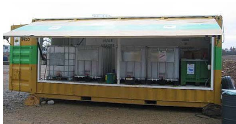
Stockage de produits polluants sur une aire étanche, abritée de la pluie (Source Egis)
