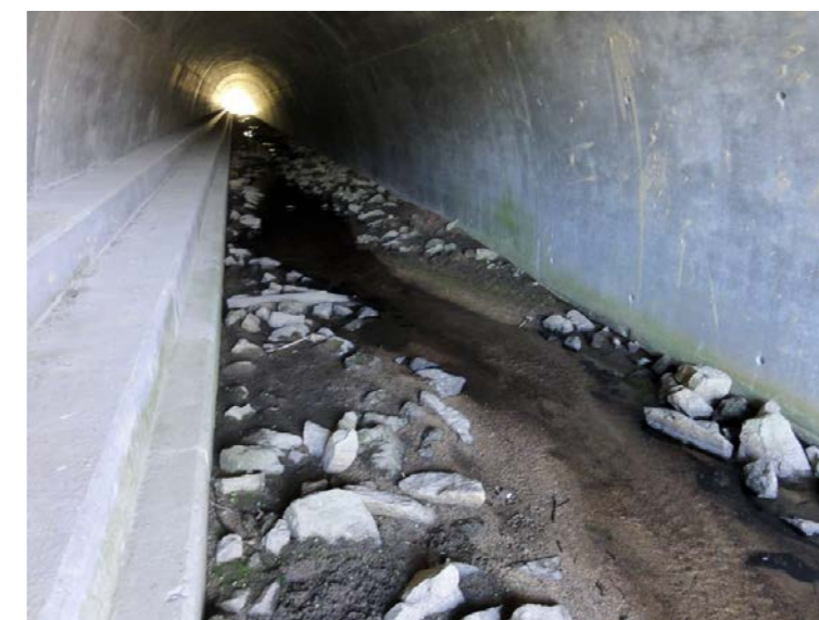
Exemple de fond reconstitué dans un ouvrage à radier artificiel [Source : Egis]
