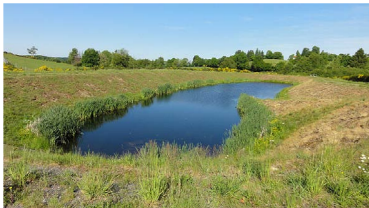
Bassin de récupération des eaux [Source : Egis, 2011]
