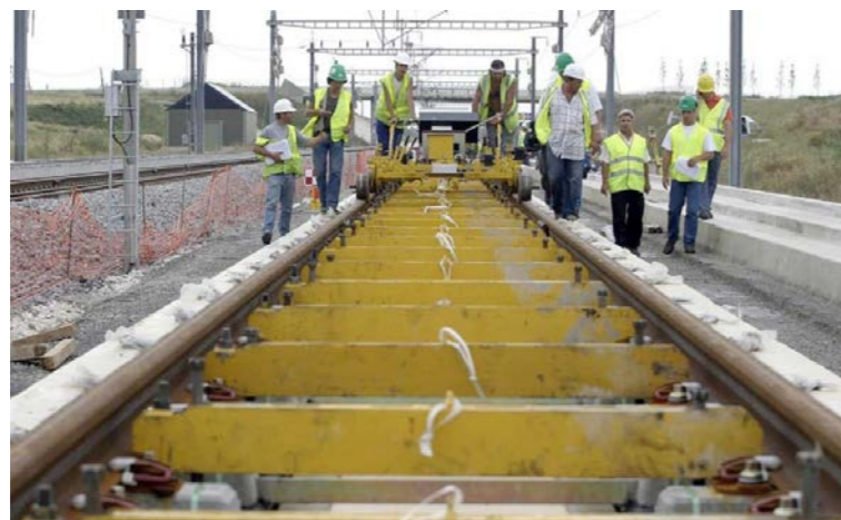
La mise en place des voies (Source : RFF)
