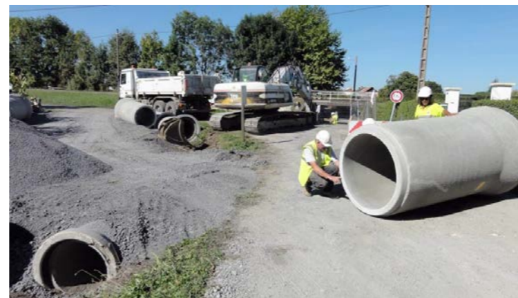
Rétablissement de réseaux [Source : Egis, 2011]
