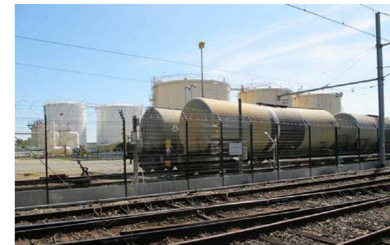
Site Total à Saint-Jory [Source : Systra]
