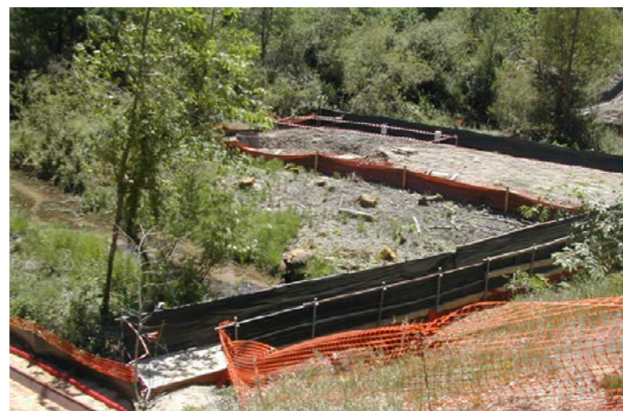
Dérivation en cours de construction avec les protections canalisant les animaux [C. Bout - GREGE]
