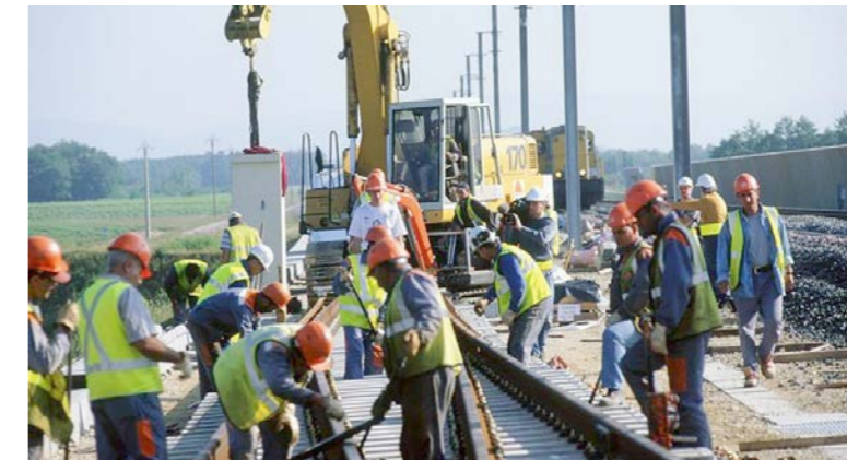
Pose des voies [Source : RFF]
