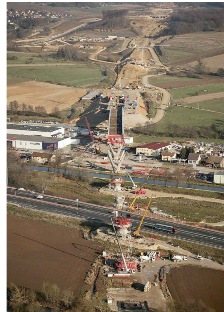
Travaux à proximité de zones urbanisées [Source : RFF]
