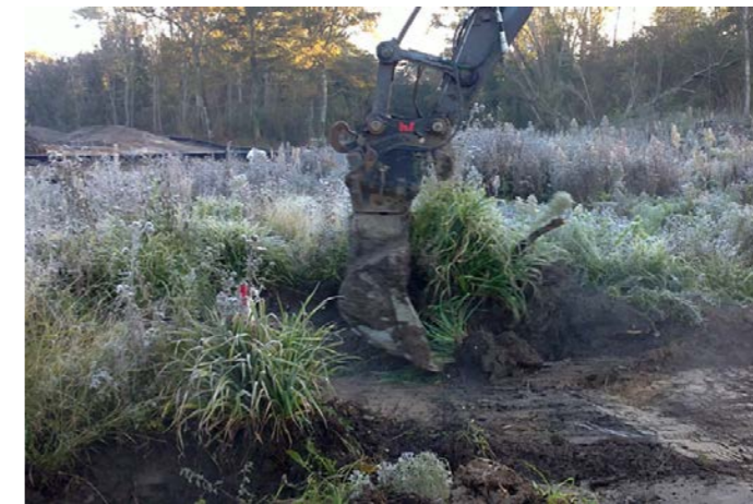
Scalpage d'une zone humide [C. Bout - GREGE]
