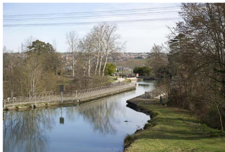
Canal latéral à la Garonne (Source RFF)
