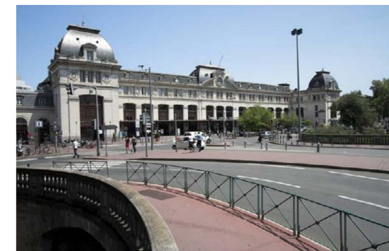
Gare de Toulouse Matabiau (Source Inexia)
