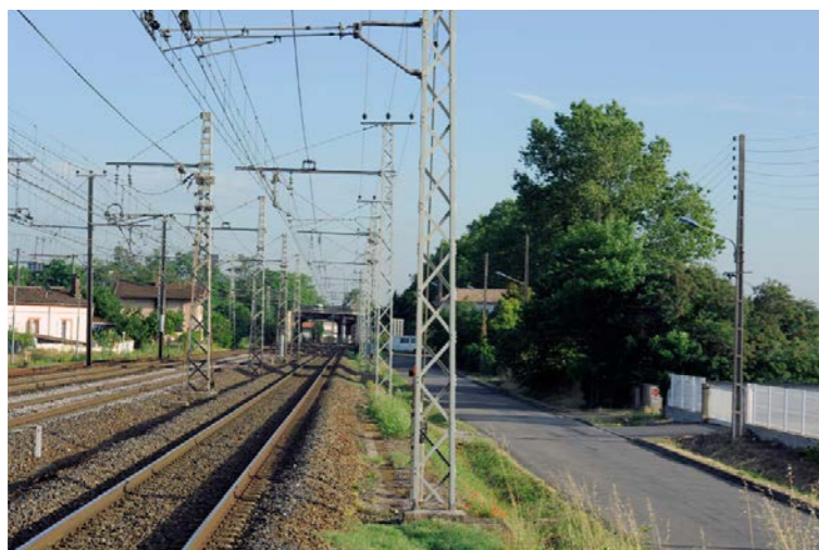
La ligne existante Bordeaux – Sète et la RD820 à l'approche de l'agglomération toulousaine [Source : Systra]
