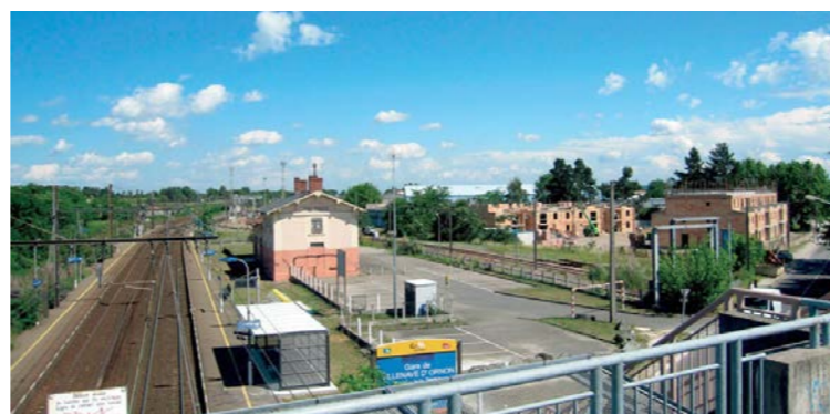
La halte de Villenave-d'Ornon en sortie de Bordeaux (source : ISA, 2011)
