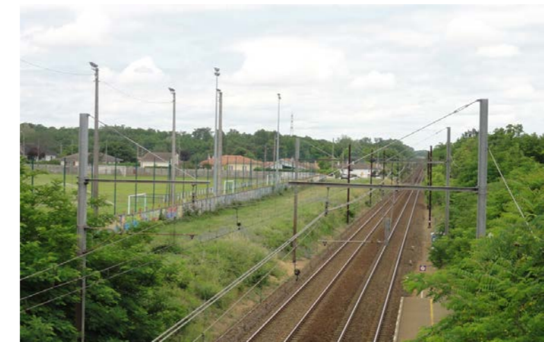
Ligne existante Bordeaux-Langon [Source : Egis, 2012]
