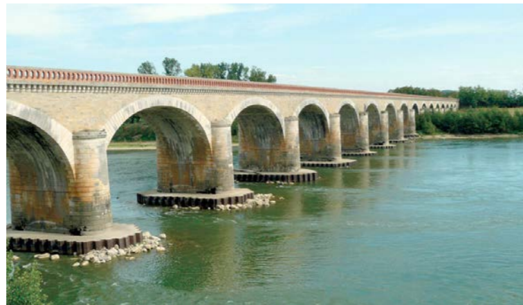
Pont ferroviaire sur la Garonne à Layrac [source: ISA, 2011]
