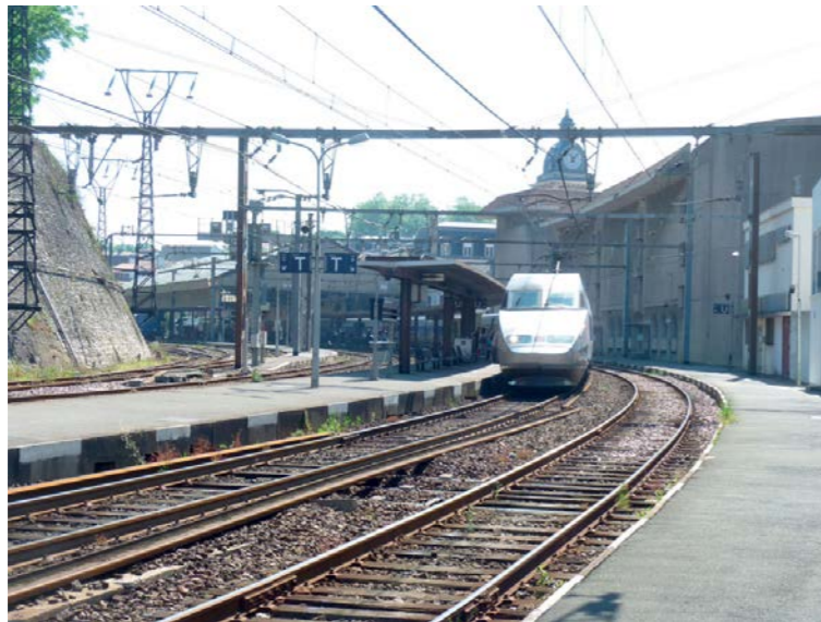
La gare de Bayonne (source EGIS Rail)
