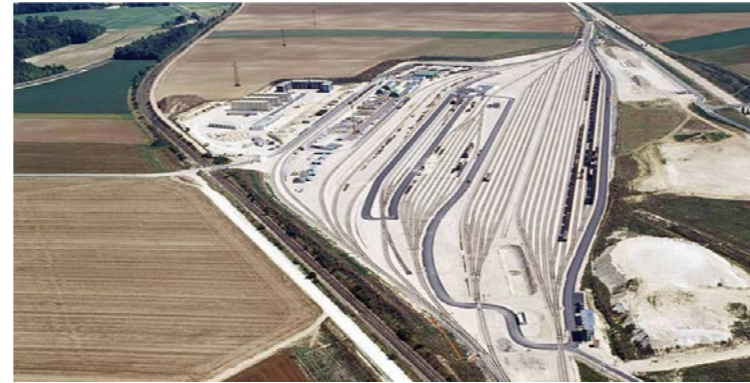
Base travaux de Vadenay – Saint-Hilaire au Temple (51) sur la LGV Est européenne (Source : RFF)
