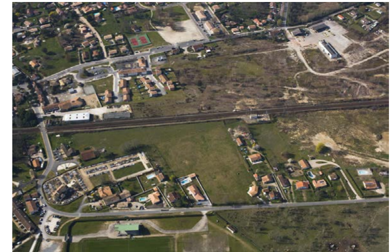
Sous-station existante à Saint-Médard-d'Eyrans (Source : RFF)
