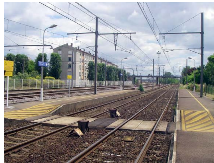
Ligne existante Bordeaux - Langon (Source : Egis, 2012)
