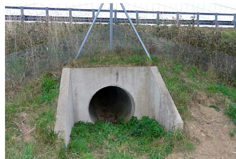
Ouvrage de type 3 [Source : Egis]
