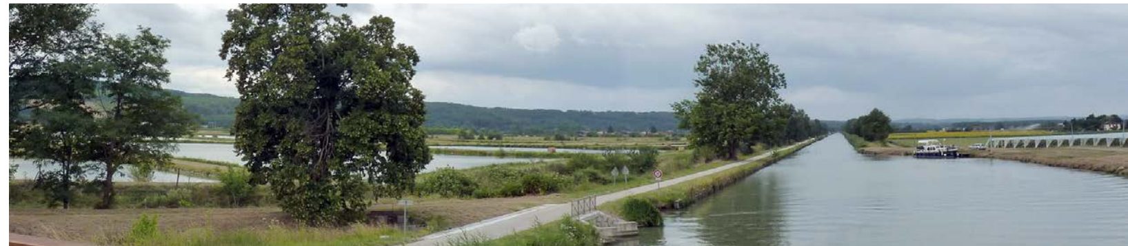
Vallée de la Garonne au niveau d'Agen [Source : Egis, 2012]
