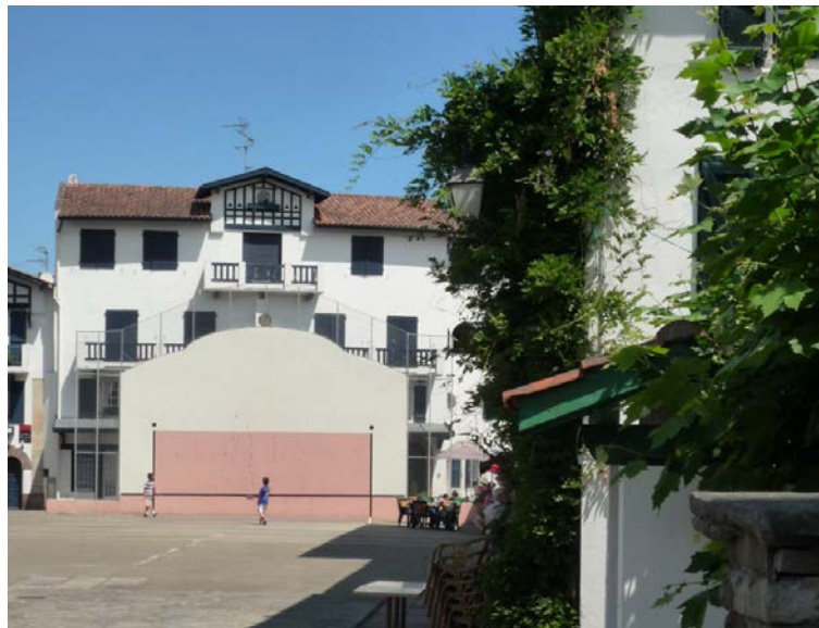
Fronton à Ascain [Source Egis rail.]
