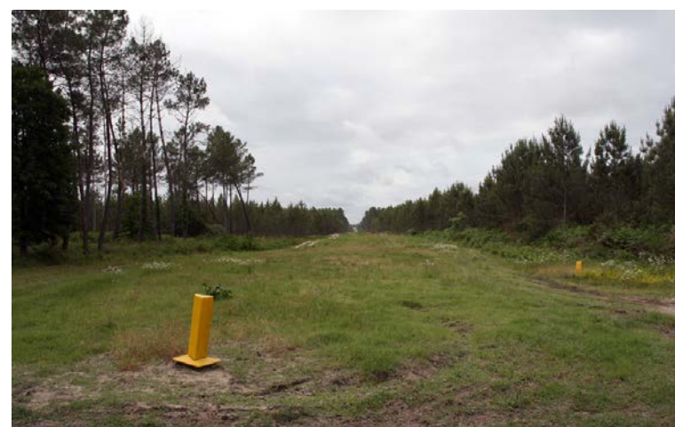
Canalisation de gaz à Cudos en Gironde (Source Egis 2012)
