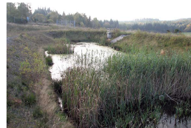
Exemple de bassin d'écrêtement. [Source : Egis]
