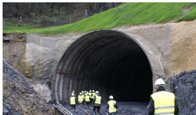
Travaux de réalisation du Y basque [Source Ineco]
