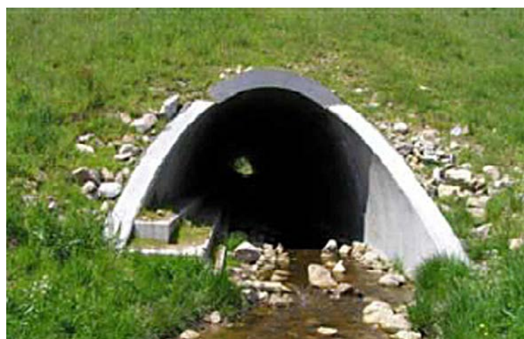
Ouvrage de type 2 : cadre avec reconstitution du lit aménagé ou non de banquettes [Source : Egis]
