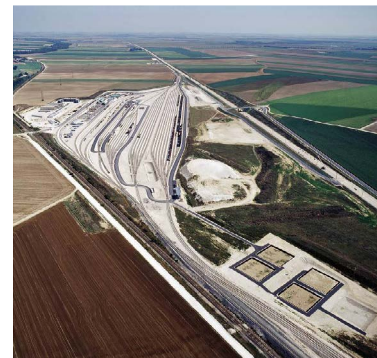
Exemple de base travaux de Vadenay – Saint Hilaire au Temple [51] sur la LGV Est européenne [Source : RFF]
