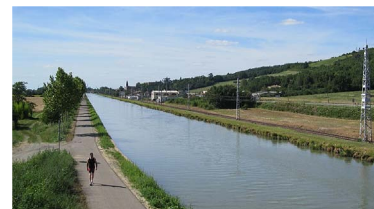
La voie verte en bordure du canal latéral de la Garonne, Saint-Rustice, Haute-Garonne, ISA
