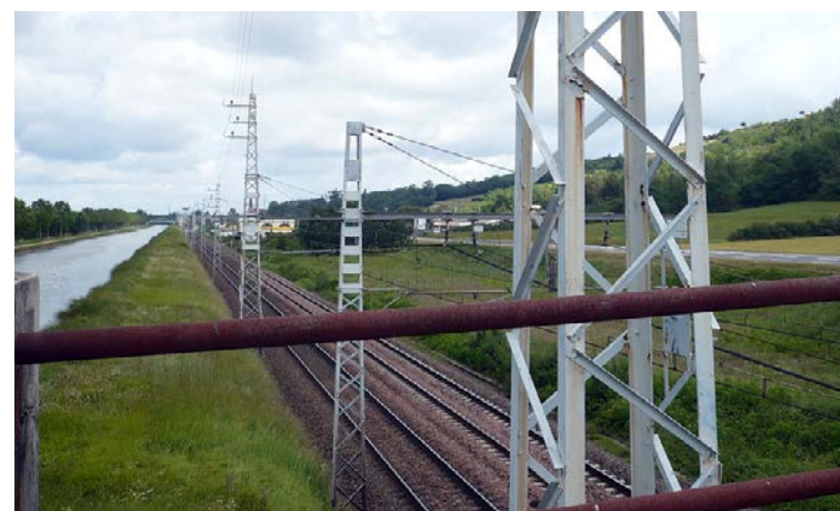
Voie ferrée à Castelnau d'Estrétefonds (source Systra)
