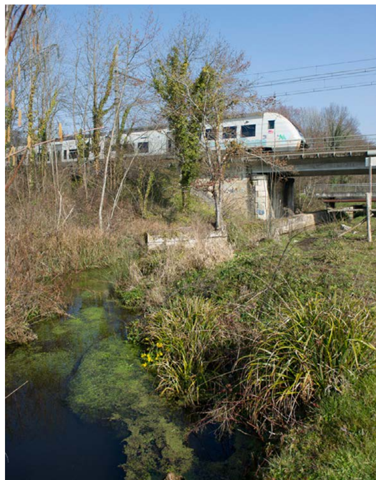
La ligne existante Bordeaux-Sète au niveau de Saint-Médard-d'Eyrans (Source RFF)
