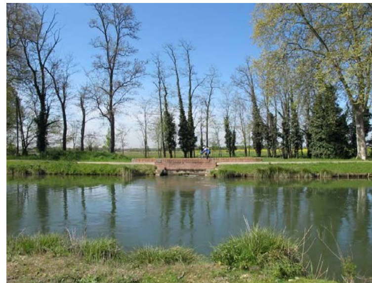
Canal latéral à la Garonne (source Systra)
