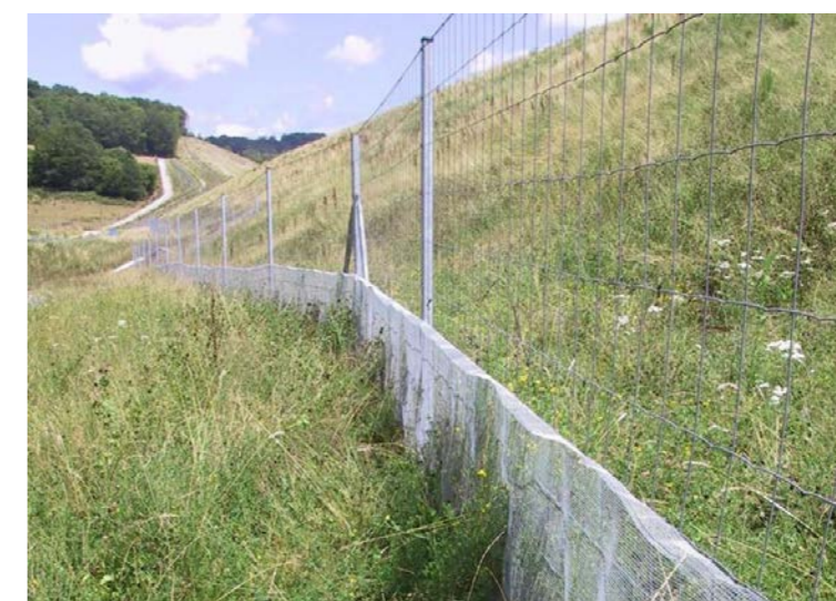
Clôture à maille fine interdisant l'accès aux amphibiens (Source : Egis)
