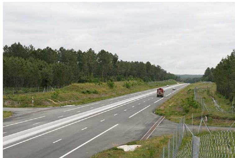
Autoroute A65 [Source Egis 2013]
