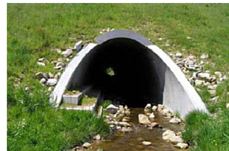
Exemple d'ouvrage aménagé avec banquettes latérales pour la faune semi-aquatique
