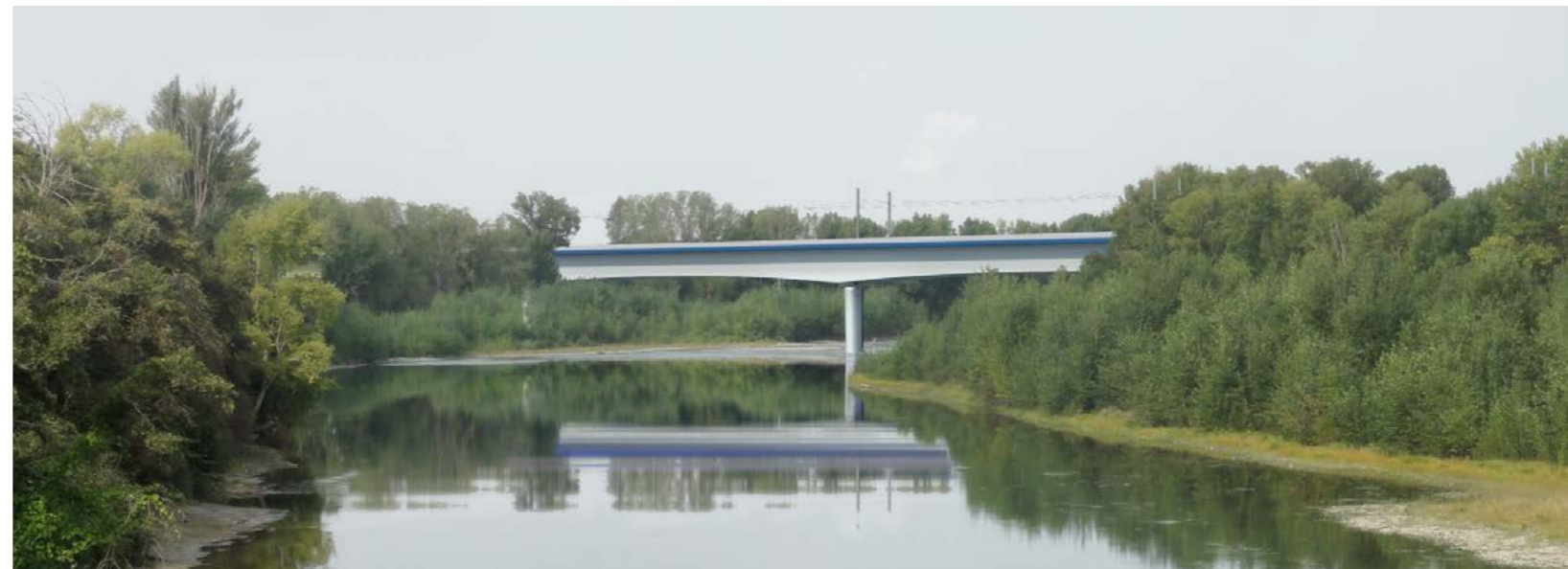
Franchissement de la Garonne aux environs de Castelsarrasin (Source : Egis)
