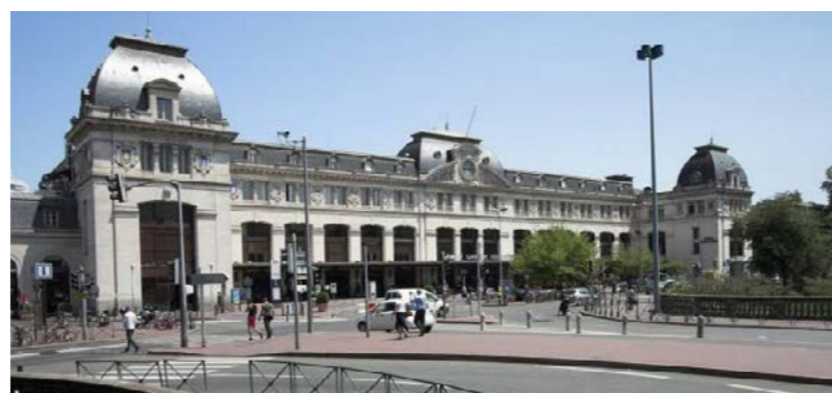
Gare de Toulouse-Matabiau [source Systra].
