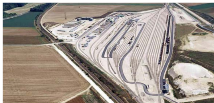
Exemple de base travaux de Vadenay – Saint-Hilaire au Temple (51) sur la LGV Est européenne [Source : RFF]
