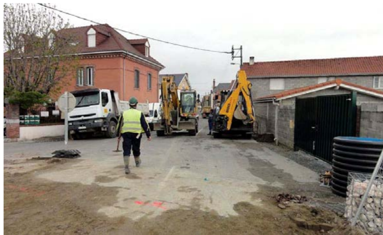
Travaux à proximité de zones urbanisées [Source : Egis, 2012]
