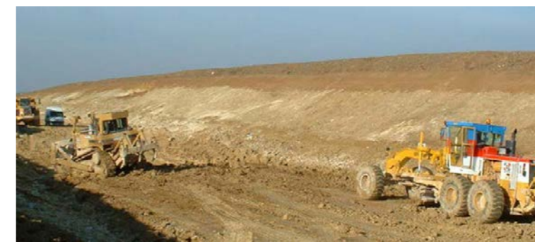
Réalisation d'un déblai - LGV est-européenne (source : Inexia)
