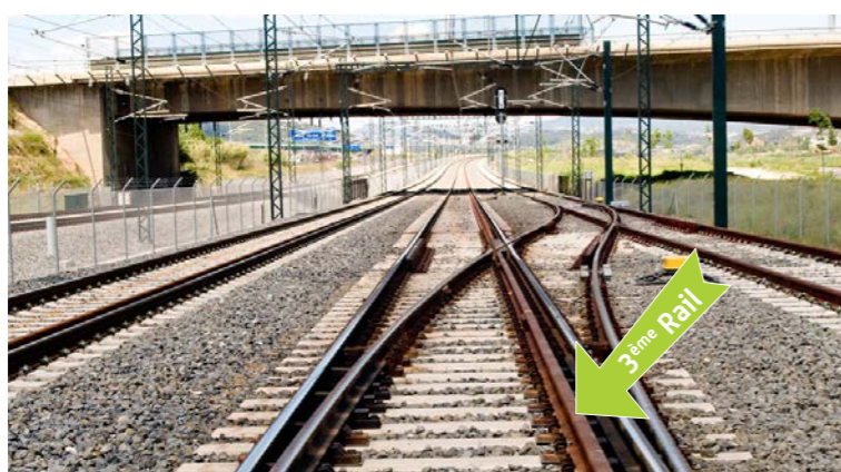
Troisième rail au Sud de la ligne nouvelle Perpignan-Figueras ver Barcelone [Source : Adf]
