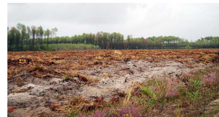
Parcelle forestière défrichée (source : Egis, 2012)
