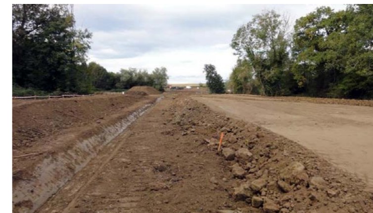
Fossé provisoire (Source Egis)
