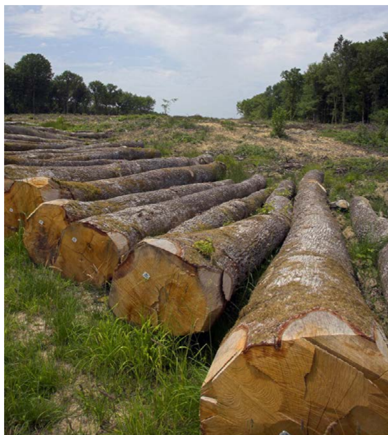
LGV Rhin-Rhône, chantier de déboisement [Source : RFF / IMATEC, 2006]
