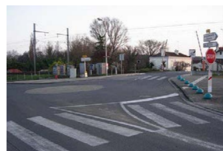
Giratoire à proximité du PN : stop pour l'av. de la Gare (source : CETE Sud-Ouest)
