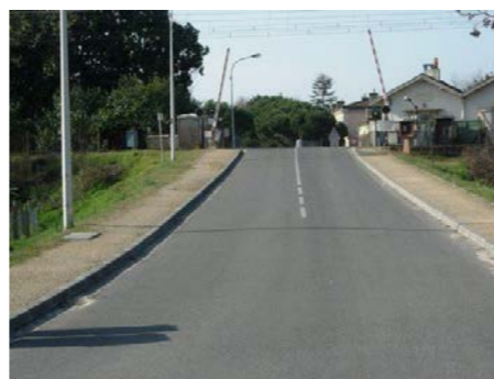
Vue depuis le côté Est [source : CETE Sud-Ouest]
