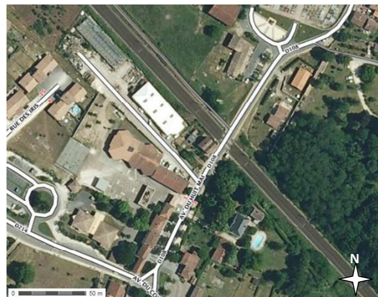
Localisation aérienne du PN n° 13 [source : Géoportail]
