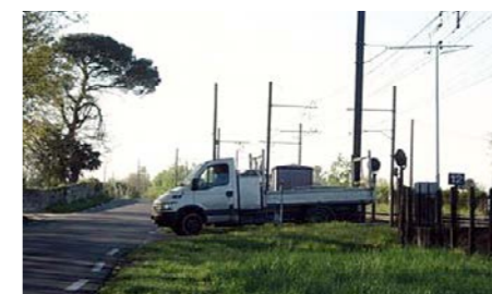
Débouché côté D108 : longueur de sas faible (source : CETE Sud-Ouest)
