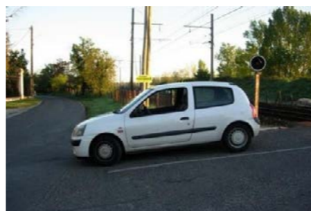
Débouché côté rue de Millefleurs (source : CETE Sud-Ouest)
