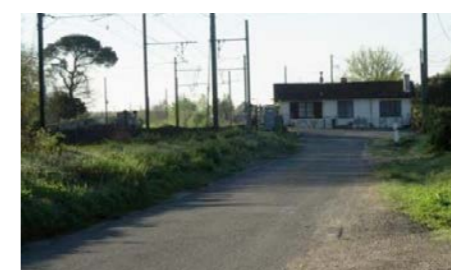
Arrivée sur le PN depuis rue d'Armeau : visibilité perfectible (source : CETE Sud-Ouest)
