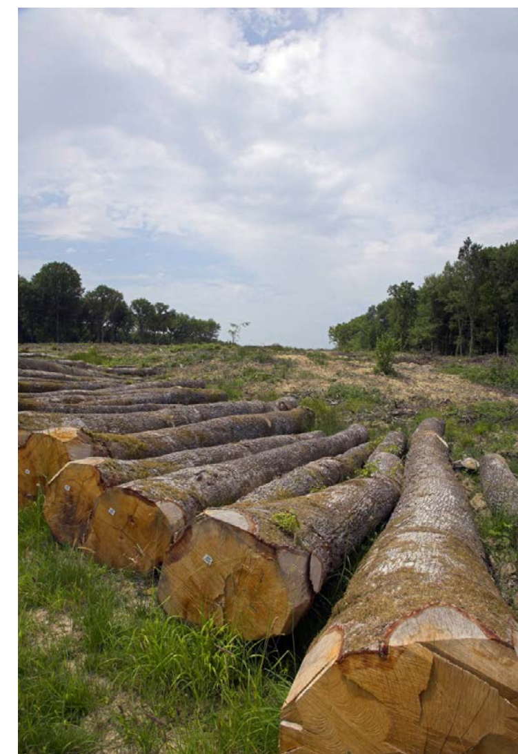
LGV Rhin-Rhône, chantier de déboisement [Source : RFF / IMATEC, 2006]
