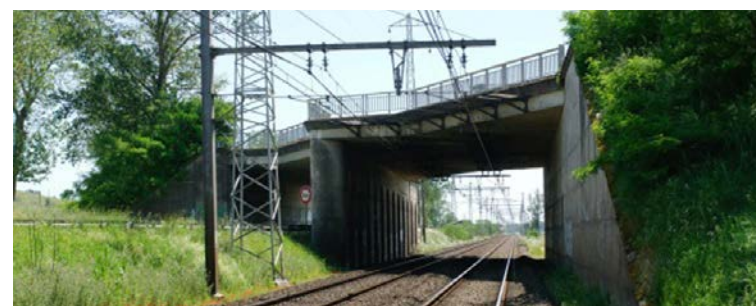
Exemple de pont-route [Source : RFF]
