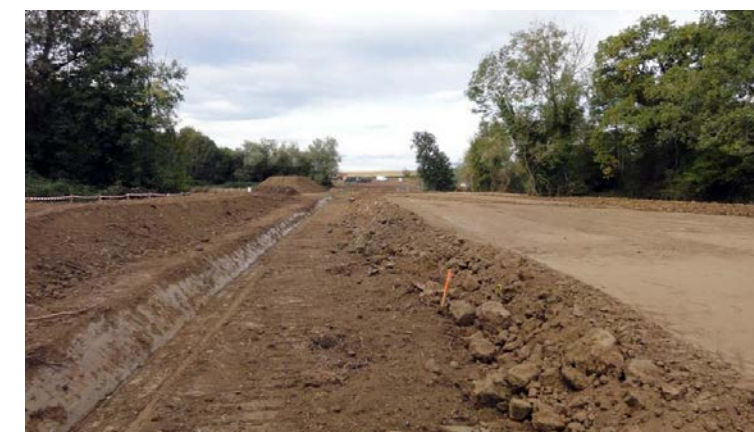
Fossé provisoire (Source Egis)
