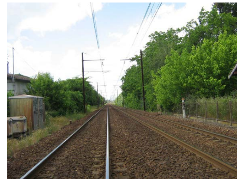
La ligne existante Bordeaux – Sète, depuis le passage à niveau n° 9, commune de Cadaujac (Source : Egis, 2012)
