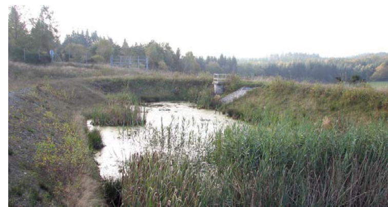
Bassin d'écrêtement (Source : Egis)
