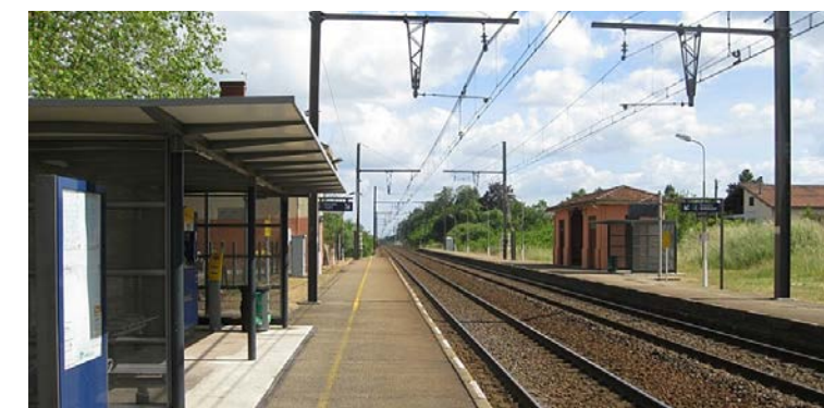
Halte TER de Cadaujac [Source : Egis, 2012]
