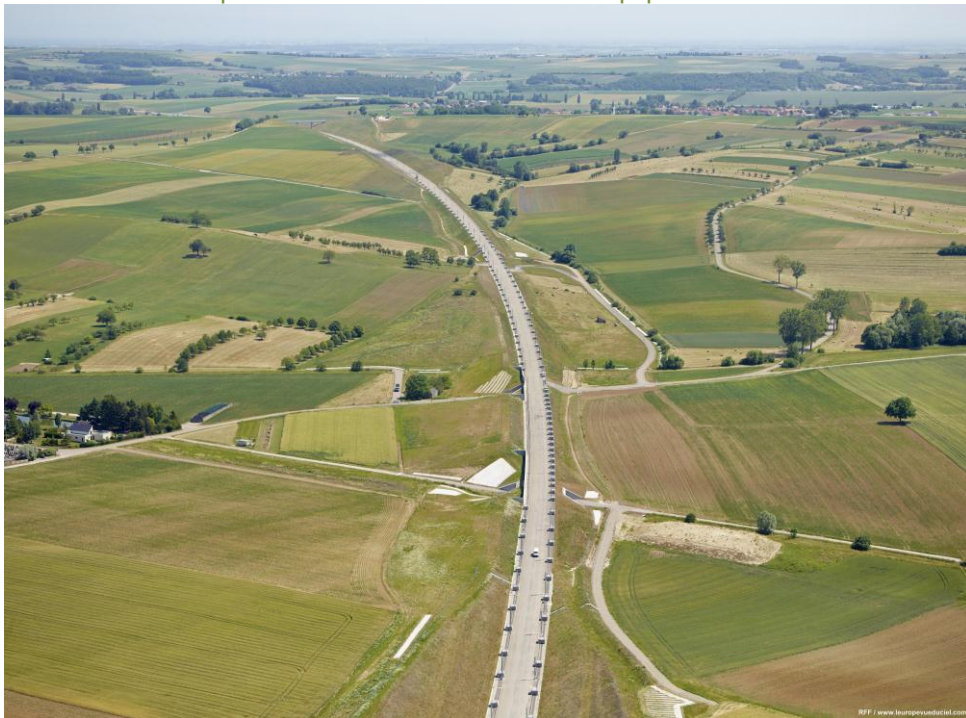
LGV Est Européenne – Phase des travaux d'équipement ferroviaire
